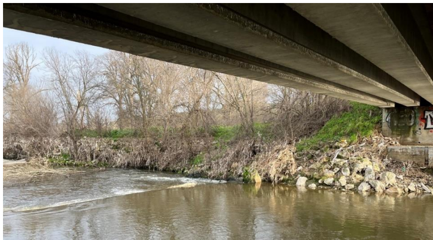
Figura 14. Cauce aguas abajo de la estación de aforo AR18. Fotografía tomada en campo (16/01/2024)
