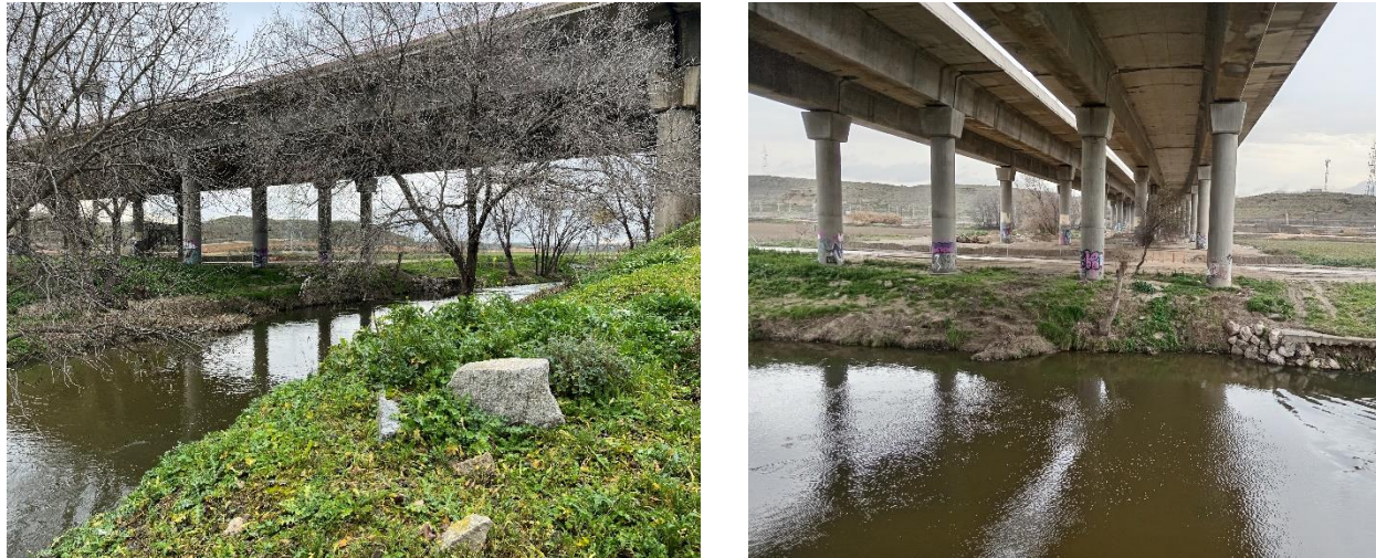
Figura 22. Autovía M-45, aguas arriba (izq.) y pilas (dcha.). Fotografías tomadas en campo (16/01/2024)
