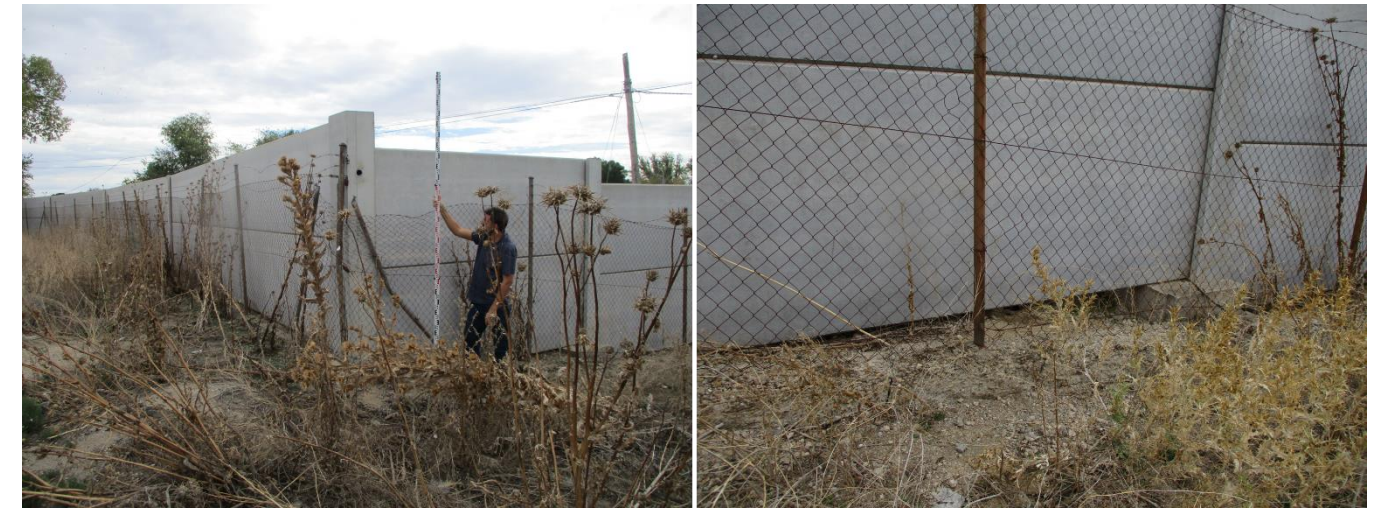
Figura 11. Muro de protección de la EDAR Sur. Fotografías tomadas en campo (2/10/2024)
