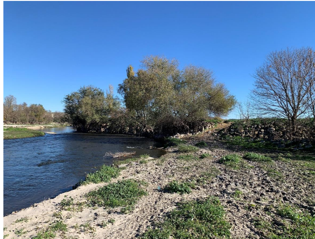
Fotografía 3. Escolleras de protección de márgenes en el ámbito de estudio.
