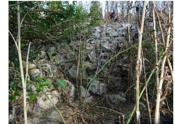
Fotografía 5. Tramo A-1, zona media
