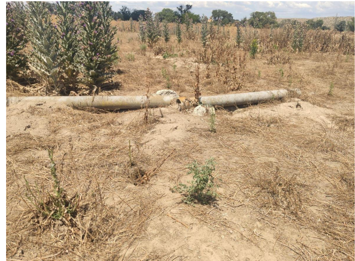
Fotografía 3. Restos de infraestructura hidráulica de riego en desuso.
