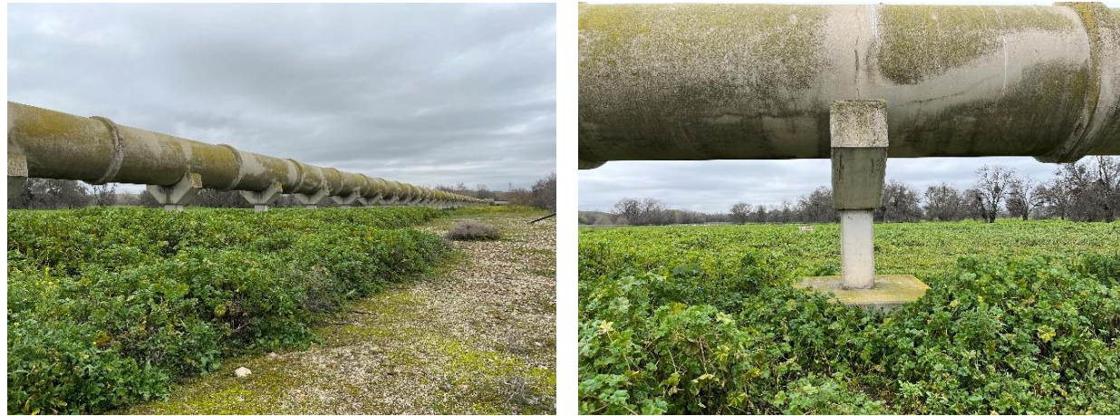
Figura 9. Conducción depuradora EDAR Sur. Fotografías tomadas en campo (16/01/2024)
