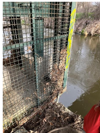
Figura 15. Restos de materia vegetal depositados por las avenidas en la verja de protección de la estación de aforo. Fotografía tomada en campo (16/01/2024)
