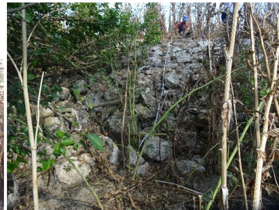
Ilustración 2. Tramo A-1, zona media
