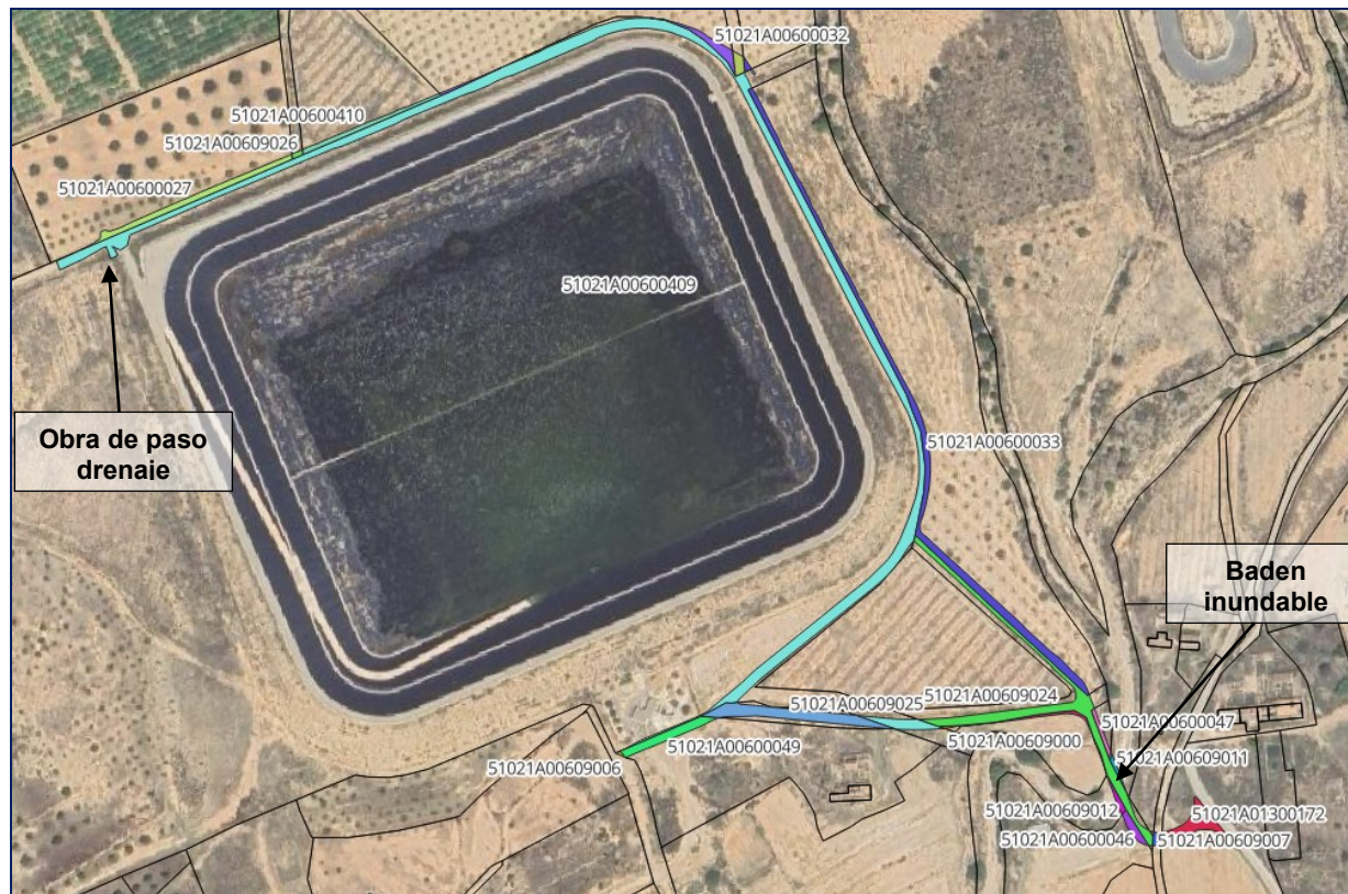
Figura 14 Identificación de parcelas afectadas por la actuación de adecuación de caminos de acceso a la balsa de Los Almagros.
