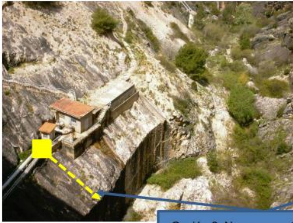
Opción 2. Nueva arqueta/ampliación de caseta existente y conducto hasta restitución al río
