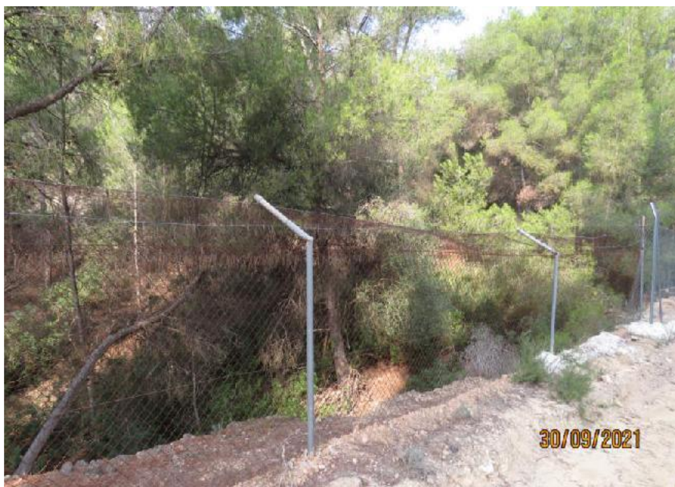
Imagen 31: vallado impermeable a la fauna terrestre y sin señalización que limita las actuales fincas.
