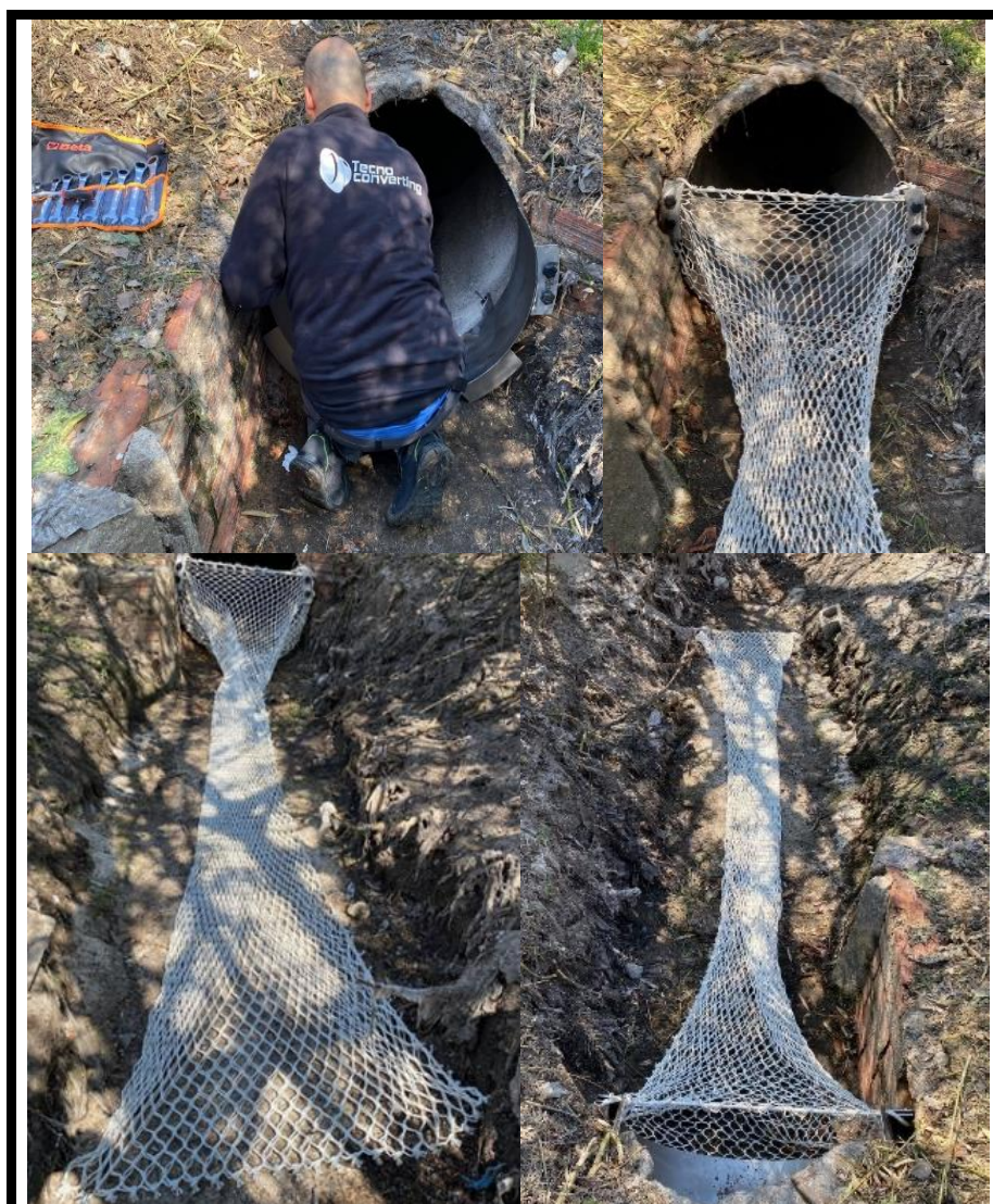
Instalación de 1 cesta Tecno-Grabber®. Mollet del Vallès (Barcelona). Cortesía de Tecnoconvertint.
