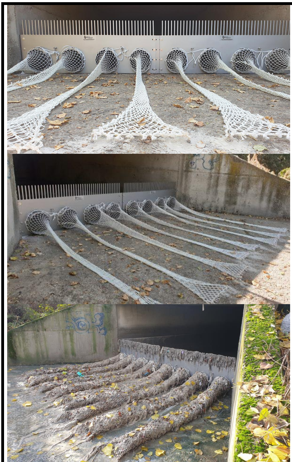
La «Sociedad Española de Ornitología» (SEO BirdLife) gestiona la instalación de un deflector con peine superior y 8 cestas Tecno-Grabber® (0,3 m de diámetro y 2 m de largo) en un aliviadero del sistema de saneamiento de Coslada (Madrid), que vierte al río Jarama. Cortesía de Tecnoconvertint.
