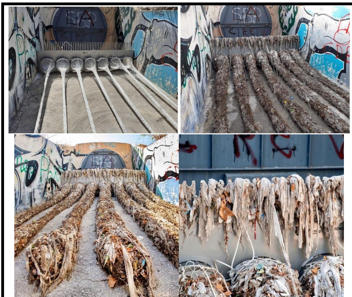
Instalación de 7 cestas Tecno-Grabber® en Aspe (Alicante). Cortesía de Tecnoconverting.
