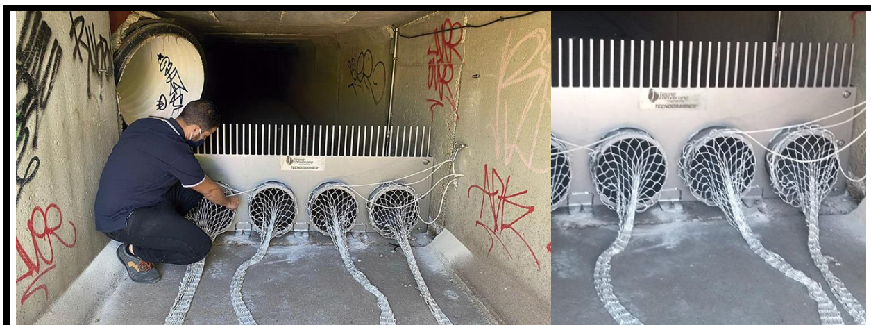
Instalación de cestas Tecno-Grabber®. Cortesía de Tecnoconverting.
