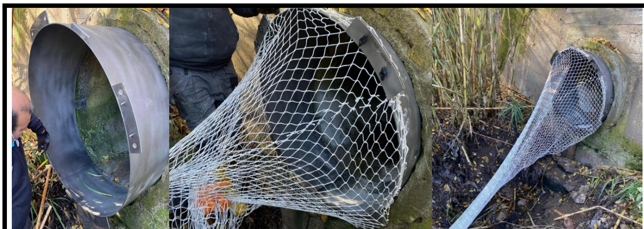
Instalación de 1 cesta Tecno-Grabber®. Sabadell (Barcelona). Cortesía de Tecnoconverting.
