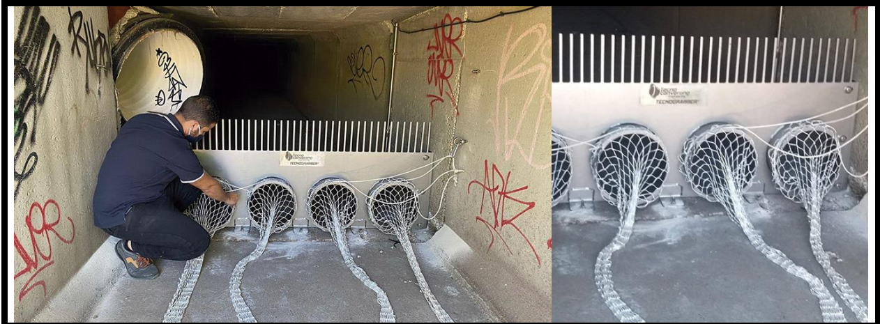
Instalación de cestas Tecno-Grabber®. Cortesía de Tecnoconverting.
