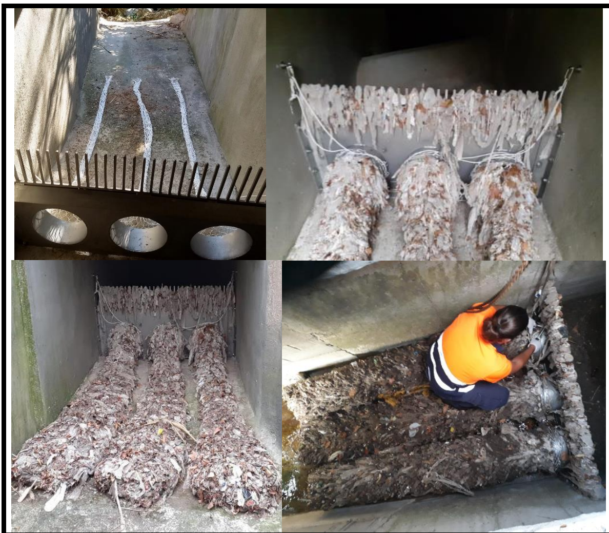
Instalación de 3 cestas Tecno-Grabber®. Cortesía de Tecnoconvertir.
