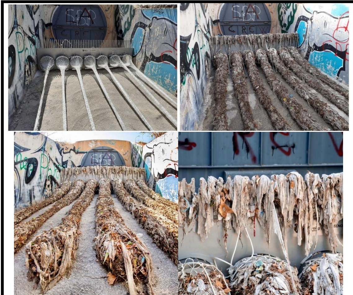
Instalación de 7 cestas Tecno-Grabber® en Aspe (Alicante). Cortesía de Tecnoconverting.
