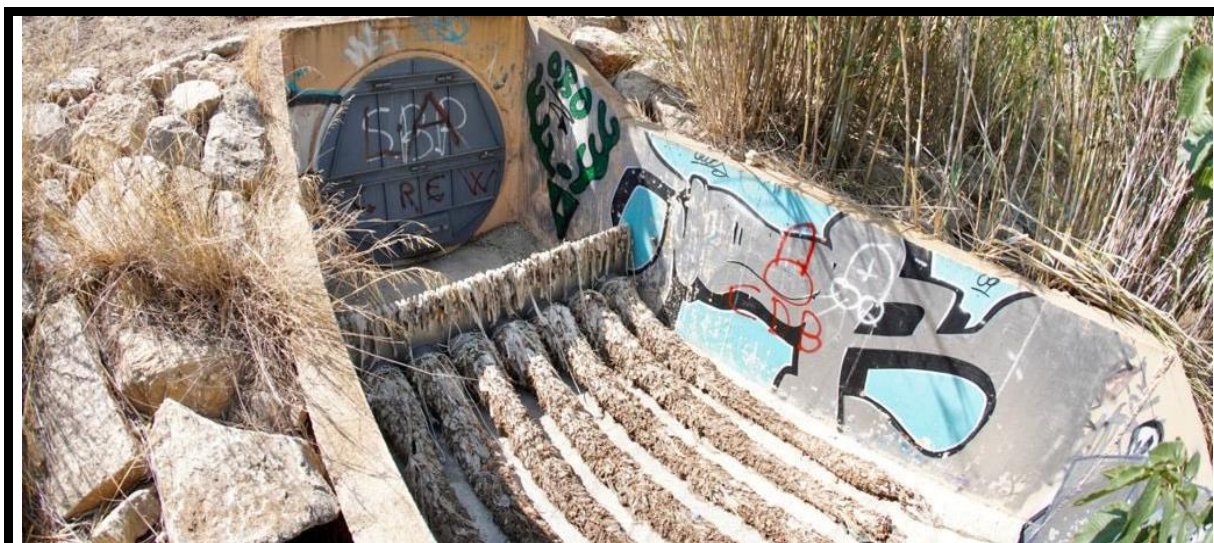
Instalación de 7 cestas Tecno-Grabber® en Aspe (Alicante). Cortesía de Tecnoconverting.
