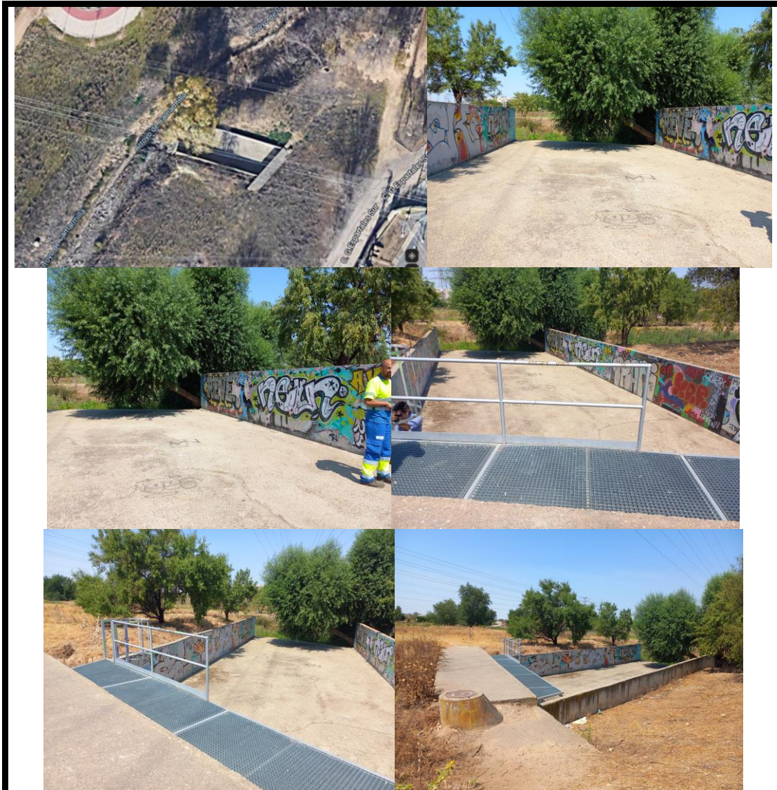
Punto de vertido por desbordamientos del sistema de saneamiento unitario, en episodios de lluvia, al arroyo de Camarmilla en Alcalá de Henares (Madrid). Cortesía de «FCC-aqualia».
