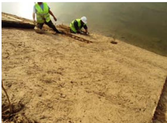
Cubriciones con adobe-paja, para impedir el rebrote de A. donax .
