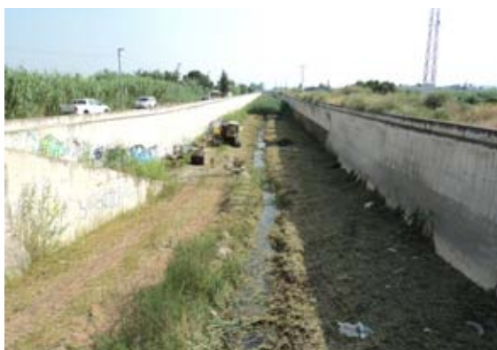
Eliminación mecánica de caña.
