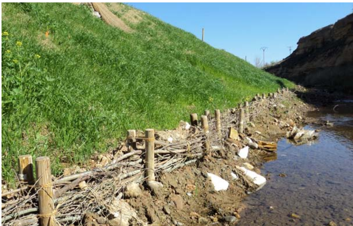
Técnica de bioingeniería. Fajina viva e hidrosiembra en el talud.
