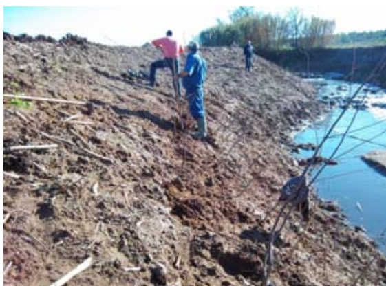
Estaquillado de especies típicas de ribera en el talud.
