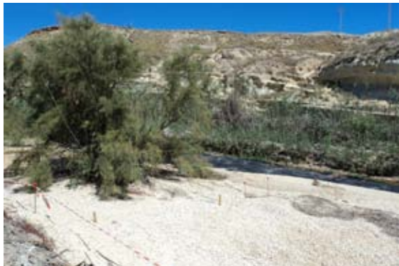
Cubrición con plástico biodegradable y aporte de tierra vegetal.
