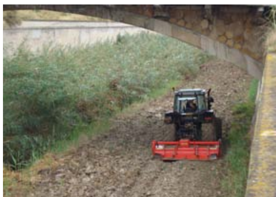
Tratamiento del suelo para eliminar el rizoma mediante rotovator.
