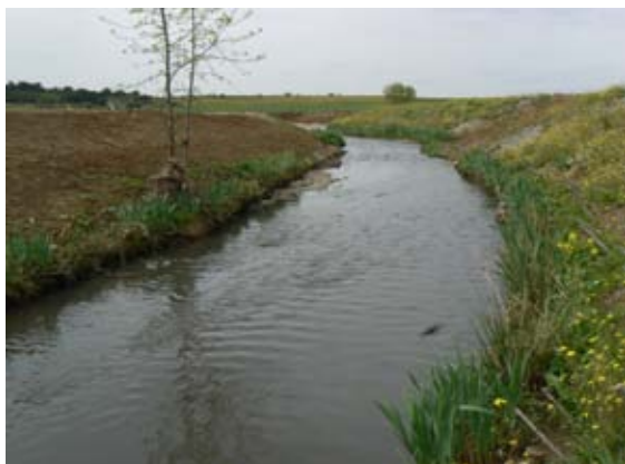
Instalación de biorrollo vegetado para proteger el pie del talud de la erosión.
