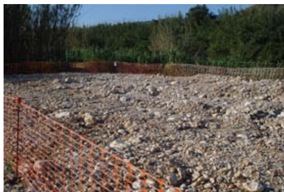
Desbroces previos de los tramos de actuación para el replanteo de las parcelas de ensayo. Parcela de ensayo delimitada mediante un cercado con malla.
