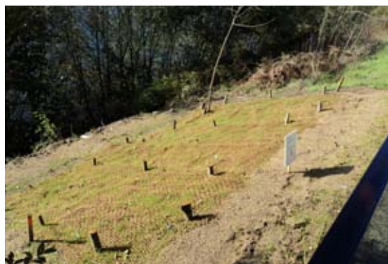
Protección del talud con redes de coco e hidrosiembra.
