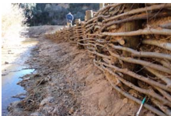
Tratamiento de protección del pie de talud mediante trenzado vivo.
