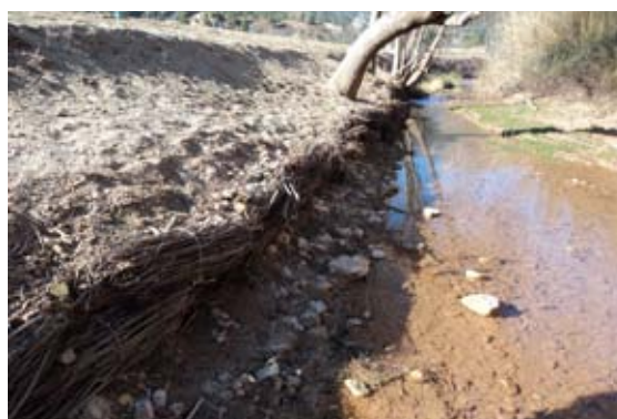
Tratamiento de protección del pie de talud mediante fajina viva.
