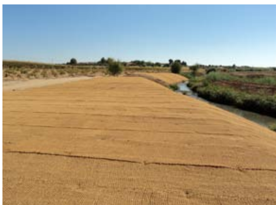
Cubrición con plástico biodegradable, aporte de tierra vegetal y sujeción con red de coco y protección del talud con cobertura de ramas vivas ( Salix sp.).
