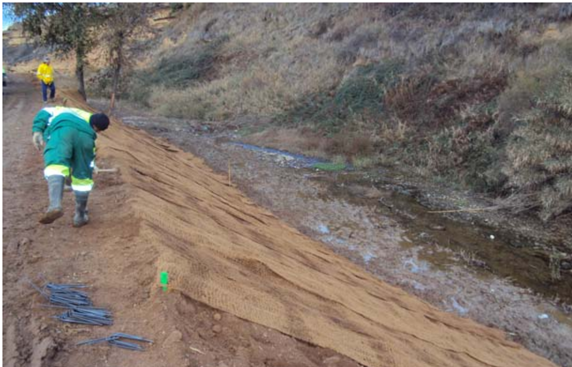
Colocación de cubriciones orgánicas (red de coco).
