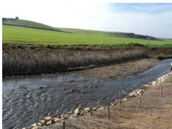
Cubrición con plástico biodegradable, aporte de tierra vegetal y sujeción con red de coco y protección del talud con cobertura de ramas vivas ( Salix sp.).
