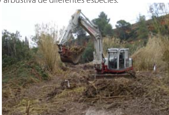
Desbroce de la parte aérea y extracción de los rizomas hasta una profundidad de 50 cm.
