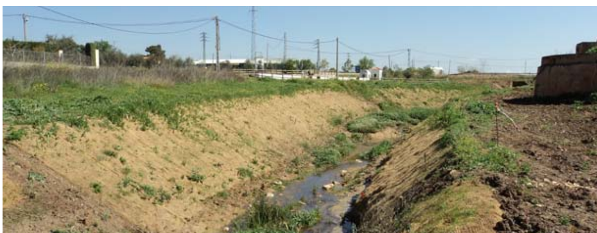
Cubriciones orgánicas con redes de coco. Evitan la erosión e impiden el rebrote de A. donax .
