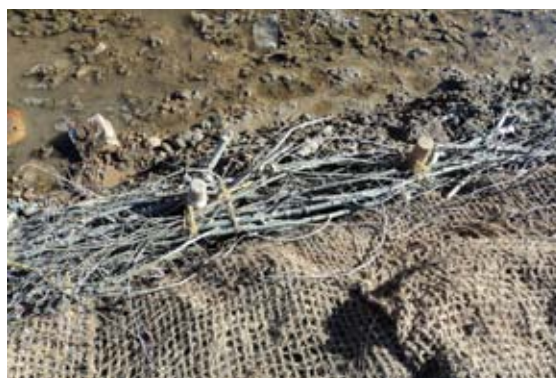
Utilización de técnicas de bioingeniería como la fajina viva.
