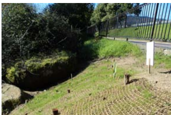
Eliminación de caña y rizoma, y colocación de redes orgánicas.
