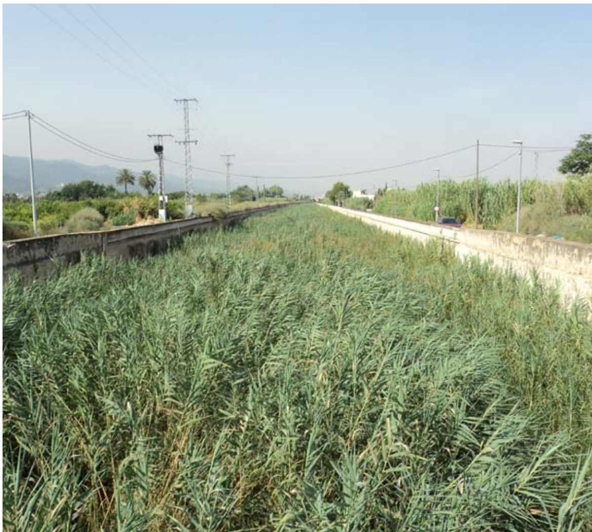
Estado inicial de la vegetación invasora ( Phragmites australis ) en el Canal del Reguerón.
