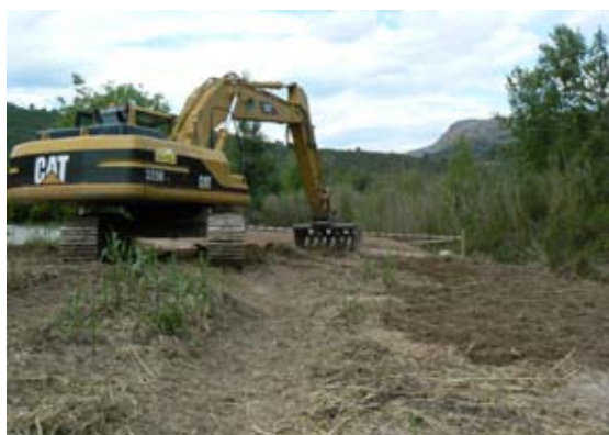
Cribado de la tierra y rizomas mediante un cazo modificado.
