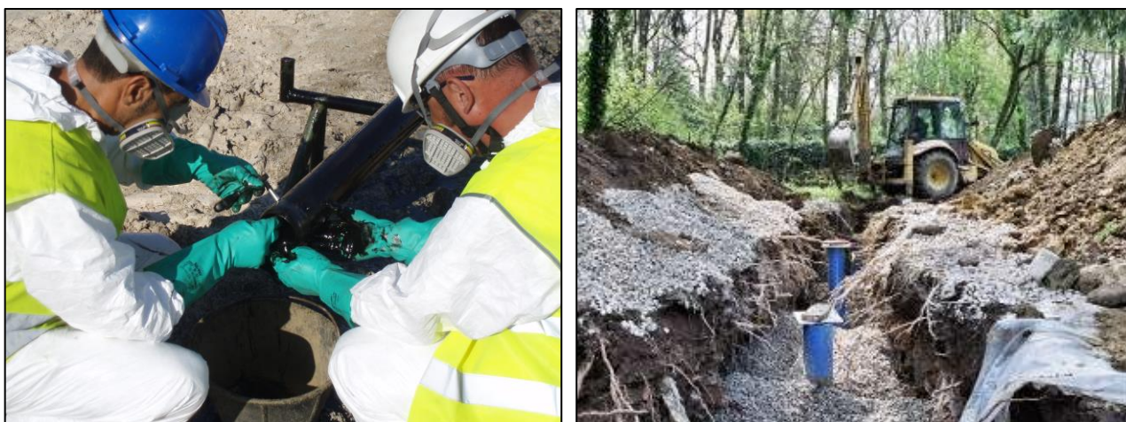
Figura 4. Actuaciones de urgencia: Izda.: Extracción de producto libre; Dcha.: Barrera hidráulica.
