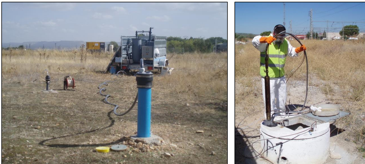
Figura 31. Actuaciones de descontaminación. Bombeo y tratamiento.
