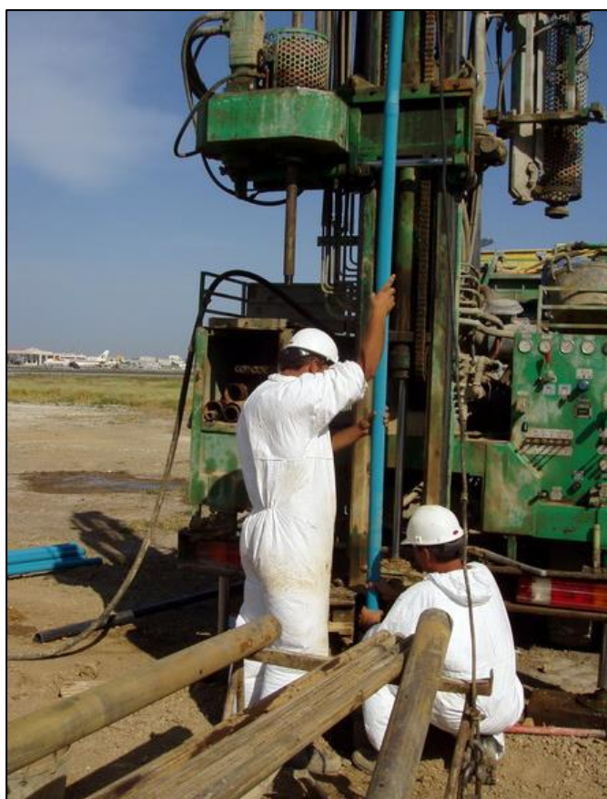
Figura 5. Investigación de la afección.
