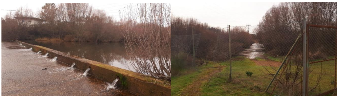
Figura 12. Punto GN00000095 (Arroyo Valdefuentes en Central de Valdecaballeros)
