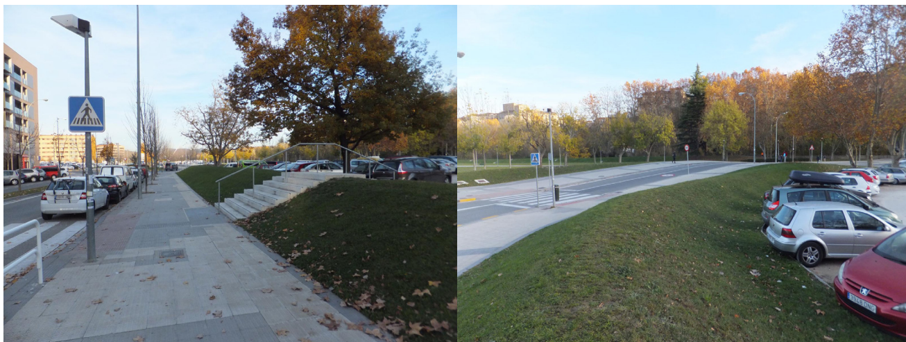
Figura 40. Motas entre el río Arga y la primera línea de edificación.
