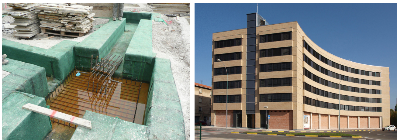
Figura 30. Protección cimentaciones con bentonita.
