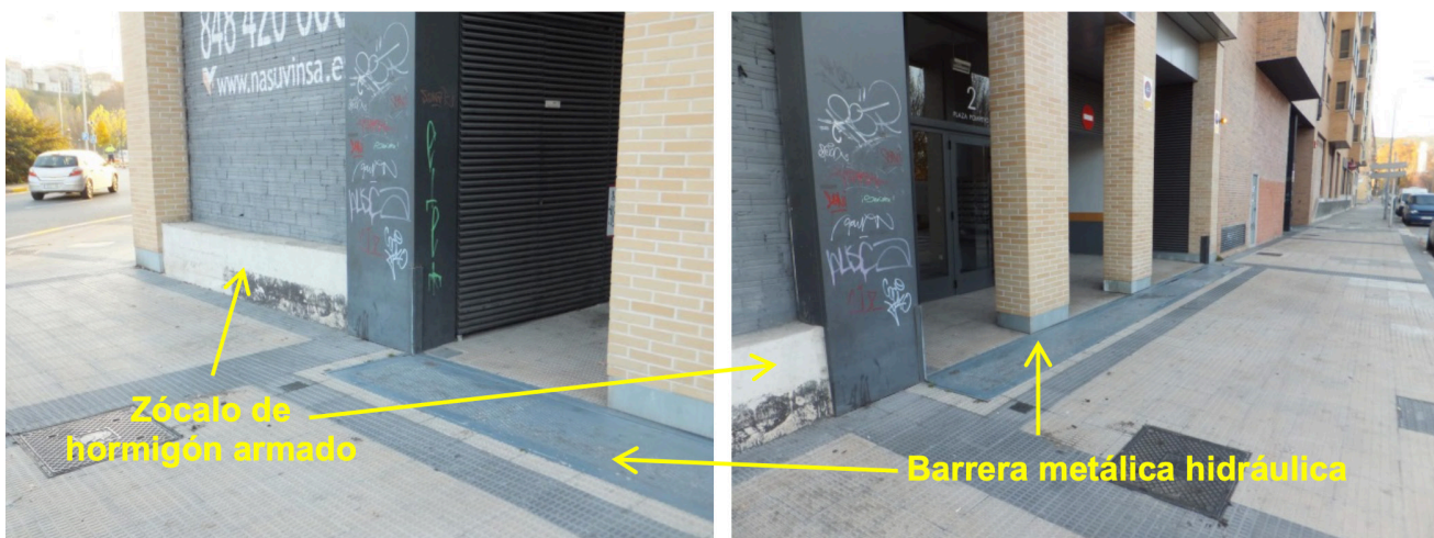
Figura 29. Medidas de contención: Zócalo de hormigón armado estructural y barrera metálica hidráulica.
