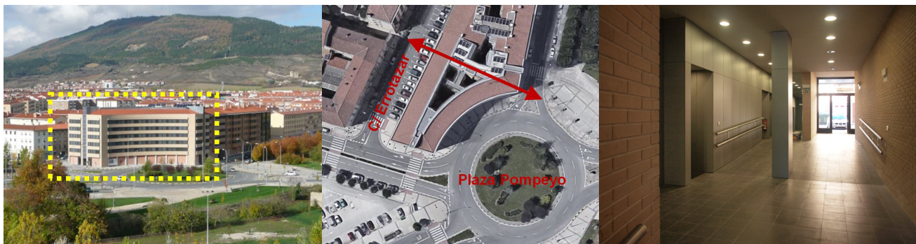
Figura 28. Viviendas de Protección Oficial en Rochapea, Pamplona.
