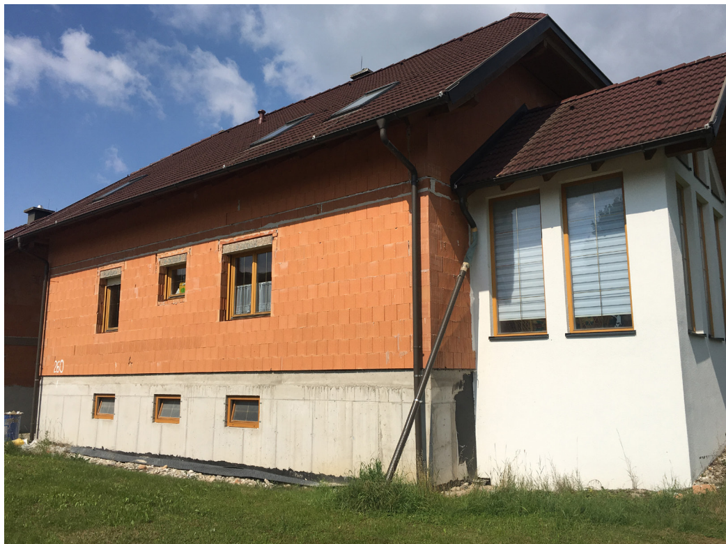
Figura 19. Materiales y aberturas resistentes en cota inundable.
