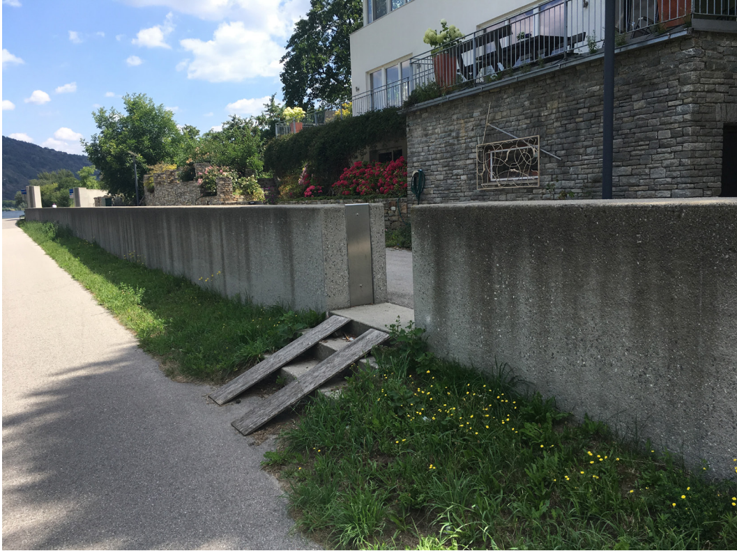
Figura 35. Muro estanco de protección.
