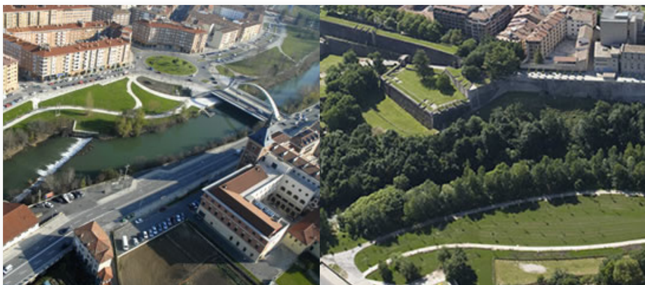
Figura 39. Parque fluvial del río Arga (tramo Rochapea y Runa II).
