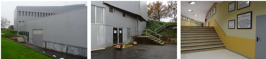
Fig. 16: Límites de la zona inundable (T=500) en el exterior del edificio (accesos M2 y M10), y límite de la zona afectada por la inundación en junio de 2018 en el interior del edificio (escalera A).
