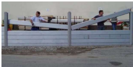
Fig. 41: Barreras temporales DPS 2000. CAG Canalizaciones.
