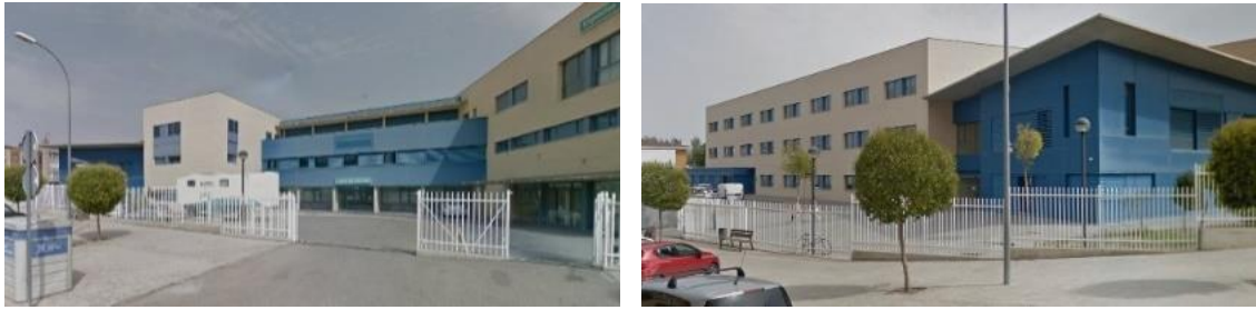
Fig. 38: Centro de Salud de Fraga. Google Maps.
