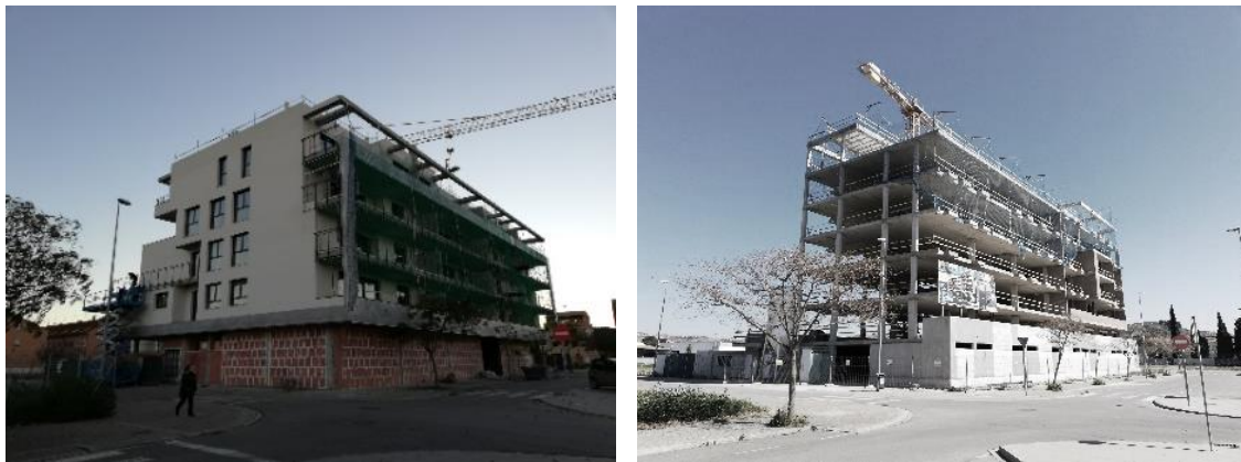
Fig. 11: Construcción de nuevos usos residenciales con planta inundable. Ayuntamiento de Fraga.
