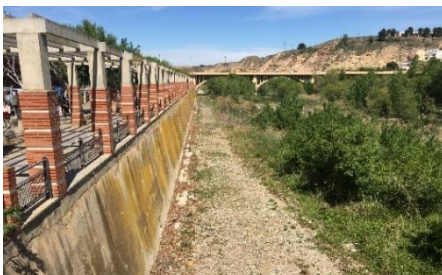
Fig. 67: Muro de hormigón en el río Cinca en Fraga. Grupo Tragsa.
