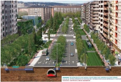
Fig. 73: Piloto de intervención Avenida Gasteiz – Río Batán. El anillo verde interior: hacia una infraestructura verde urbana en Vitoria-Gasteiz.
