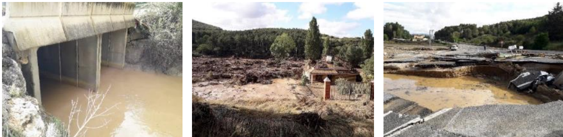
Fig. 31: Taponamiento, embalsamiento e incisión en inundación en Puyo (Navarra). Confederación Hidrográfica del Ebro.
