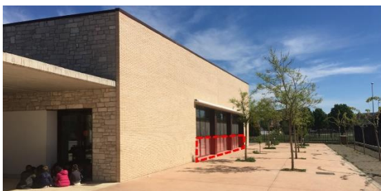
Fig. 45: Medidas para resistir h<1.5m: antepechos, sellado parcial de umbrales, protección temporal en rejillas y sellado de juntas.
