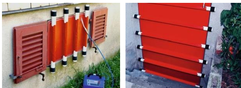
Fig. 29: Ejemplos de sellado puntual provisional. Flood proofing in urban areas. 2019.
