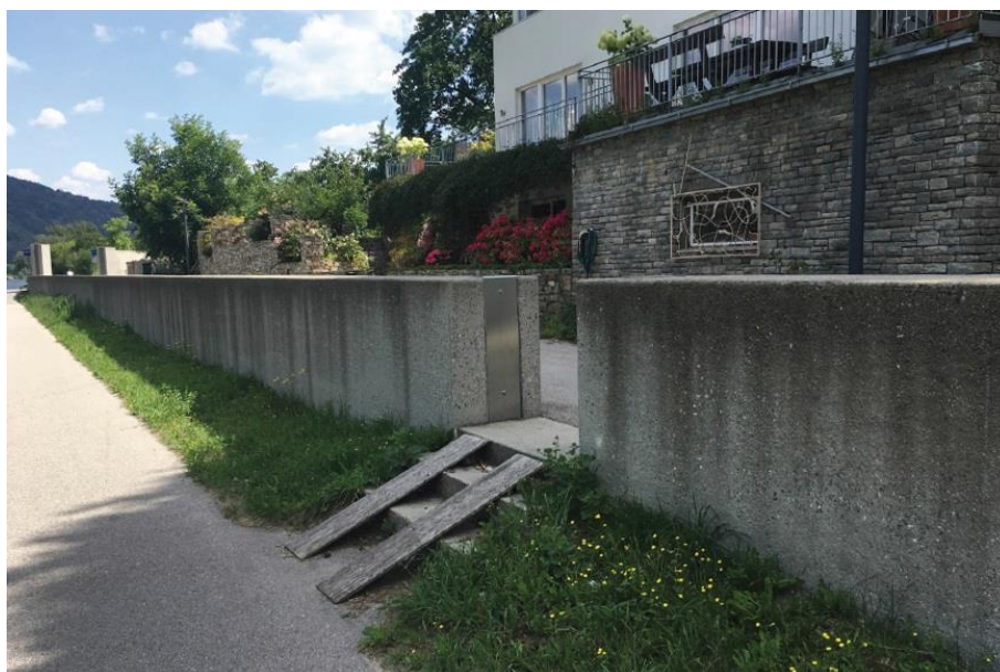
Fig. 25: Muro de protección. Grupo Tragsa.
