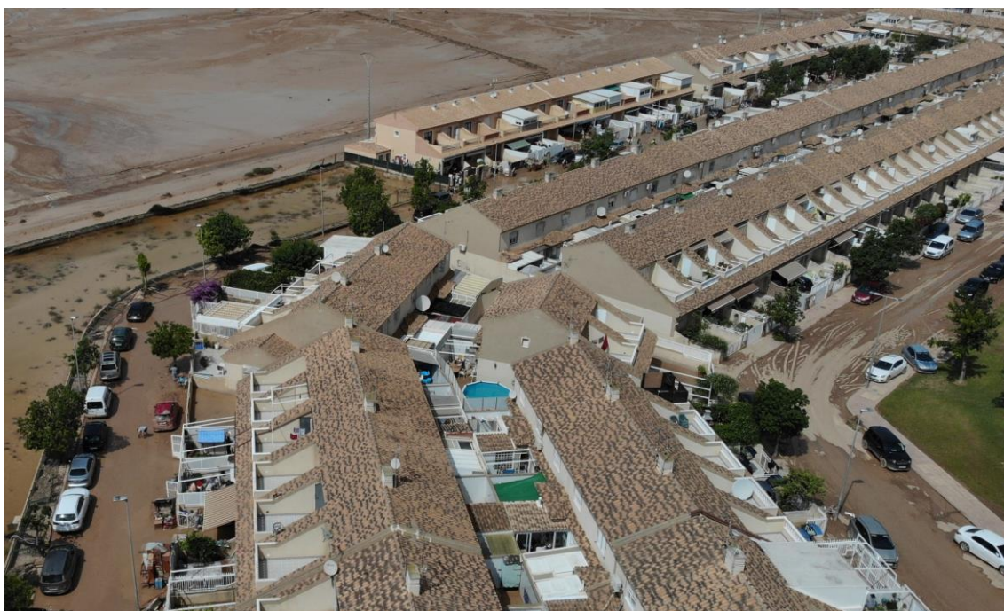
Fig. 21. Viviendas afectadas por la inundación de 2019. Ayuntamiento de Los Alcázares.
