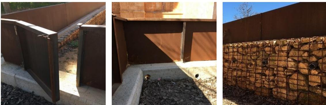
Fig. 41: Instalación de compuertas en el muro noroeste para evacuación del agua en caso de colapso del muro sudoeste.
