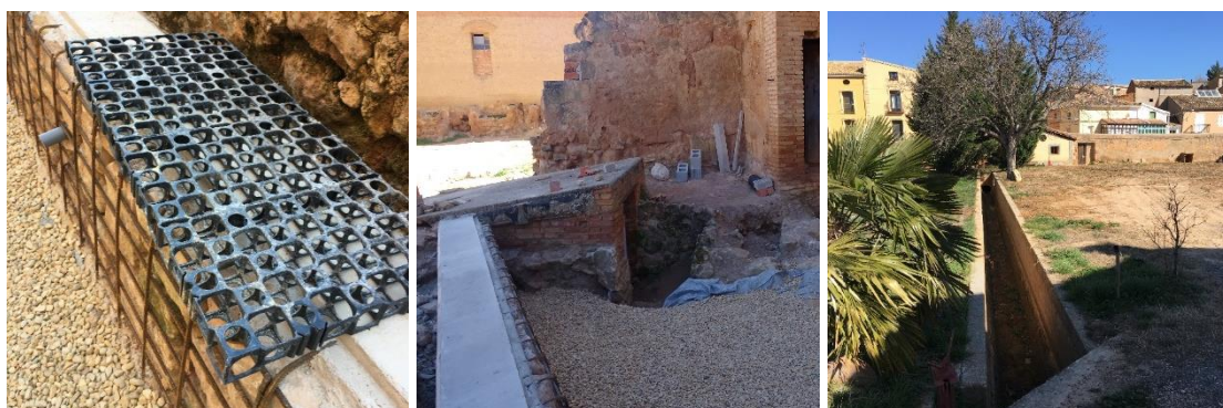
Fig. 35: Reparaciones en la red de drenaje y saneamiento.
