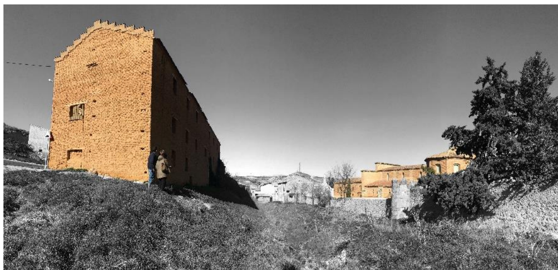
Fig. 17: Estrechamiento de la zona inundable del barranco del Tejar debido a la presencia del recinto monástico y otras edificaciones.
