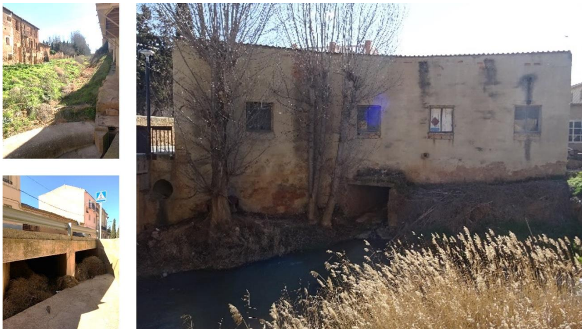
Fig. 18: Canalización subterránea del barranco del Tejar hacia el río Jalón.
