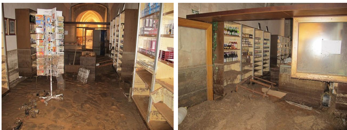
Fig. 31: Inundación en 2018: daños en equipamiento e instalaciones. Monasteriohuerta.org
