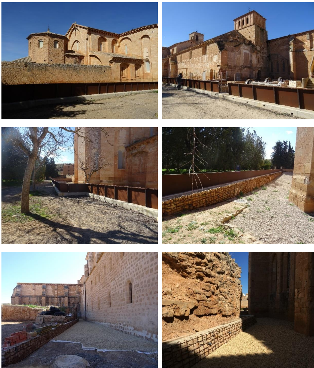
Fig. 42: Instalación de compuertas en el muro noroeste para evacuación del agua en caso de colapso del muro sudoeste.
