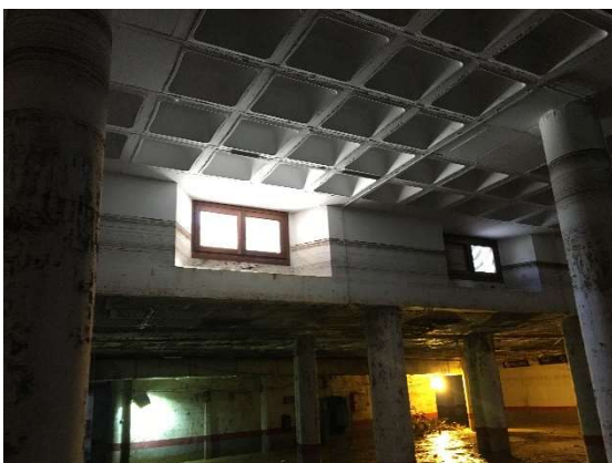
Fig. 23: Aparcamiento: huecos de ventilación e instalaciones.
