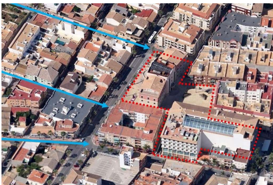
Fig. 21: Entorno del Ayuntamiento de Los Alcázares: dirección de la escorrentía.
