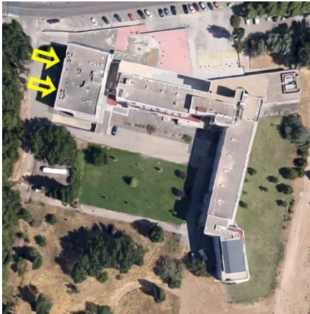
Fig. 15. Aberturas de acceso S-1 en hospital
