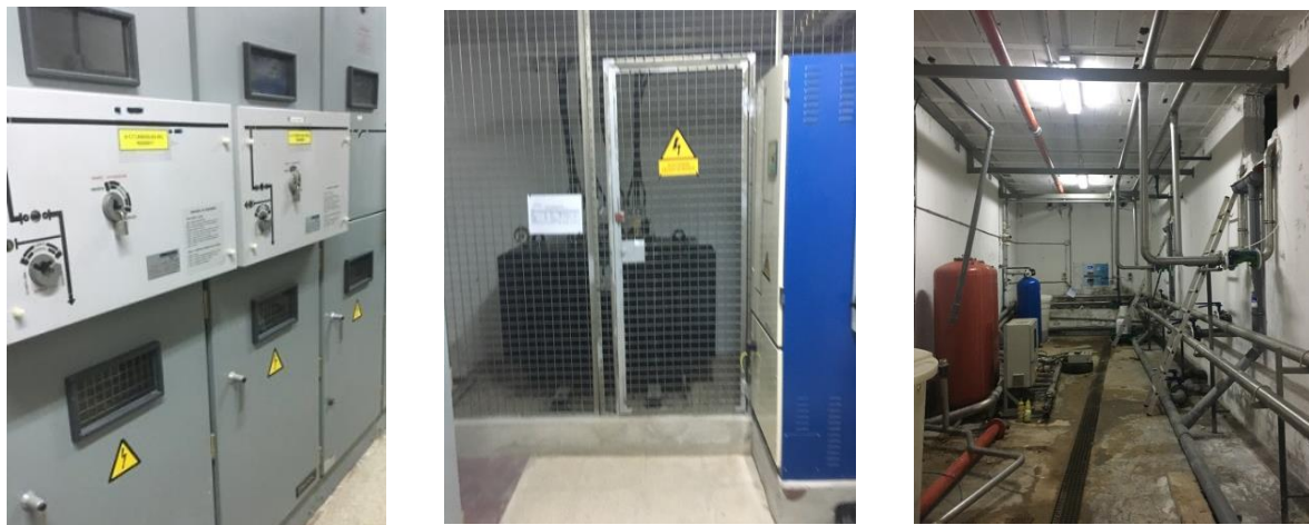
Img. 15 Recinto CT y Aljibes.
