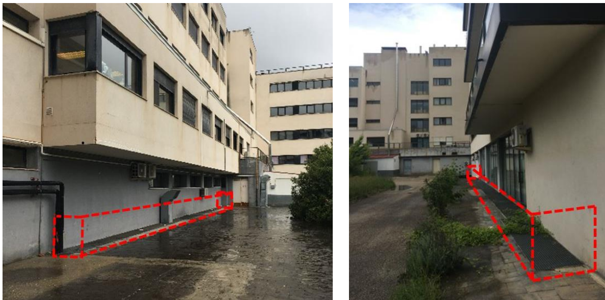
Fig. 25 Murete de protección de rejilla hospital y residencia.
