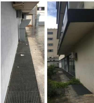
Img. 09 Rejillas en encuentro con edificio
