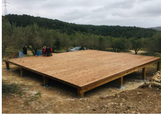
Foto 5. Ejemplo de tarima madera anclada al terreno
