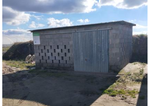
Foto 2. Caseta de bombeo
