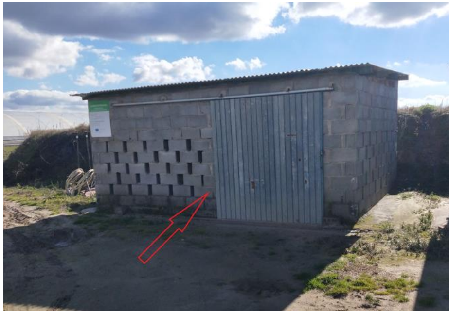
Foto 4. Puntos de entrada en la caseta de bombeo
