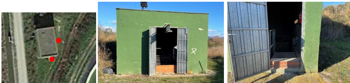
Figura 8. Accesos a la estación de bombeo
