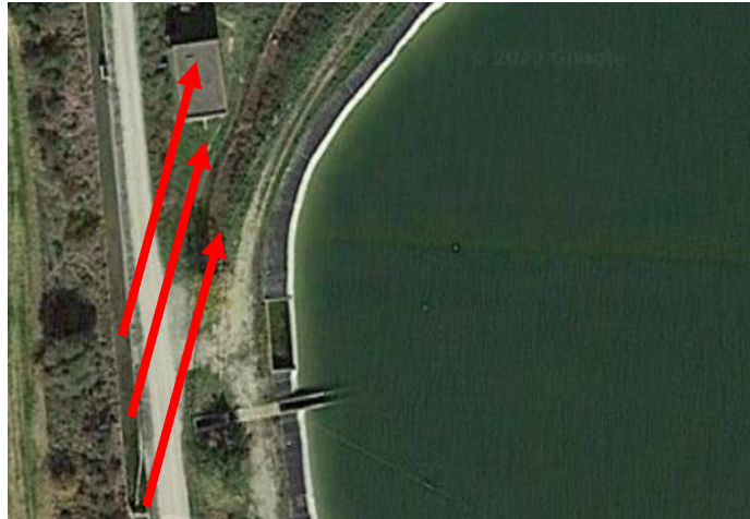
Figura 6. Obra de derivación. Zona de escorrentía no controlada en caso de inundación
