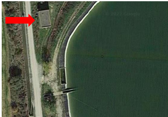
Figura 3. Entorno de la toma del canal a la balsa. Estación de bombeo
