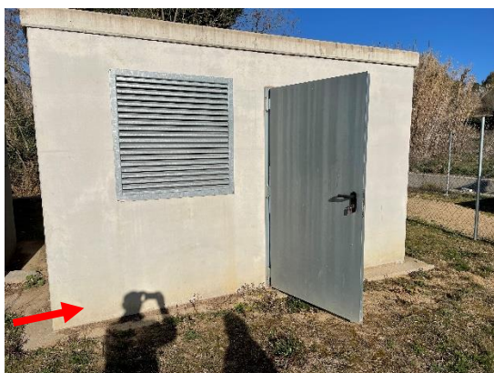
Figura 12. Caseta en zona potencialmente inundable. Grupo electrógeno.
