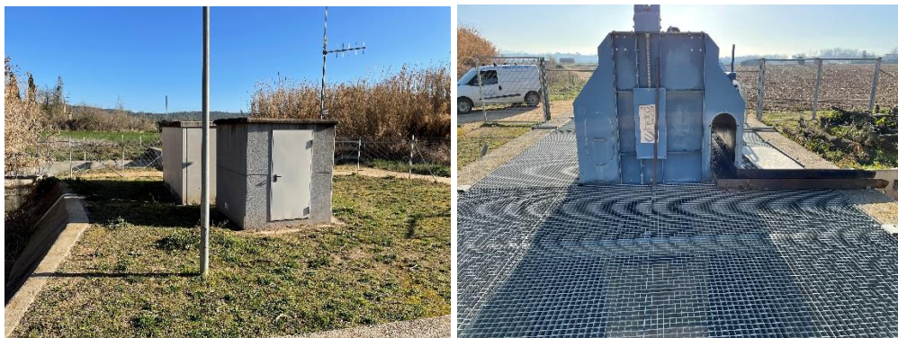
Figura 7. Toma de la tubería principal de riego. Embocadura y casetas de servicios.
