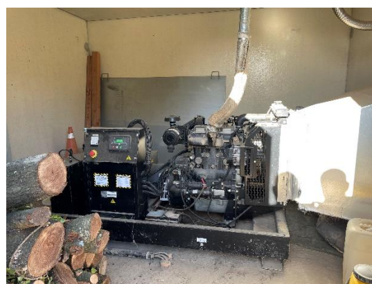
Figura 12. Caseta en zona potencialmente inundable. Grupo electrógeno.
