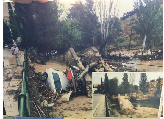
Foto 4. Obstrucciones en los puentes en la confluencia de los ríos Frío y Salado, junto a la plaza de San Isidro
