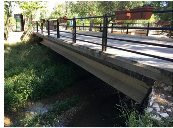
Foto 12. Puente sobre el río Salado, junto a la fase B y la plaza de San Isidro
