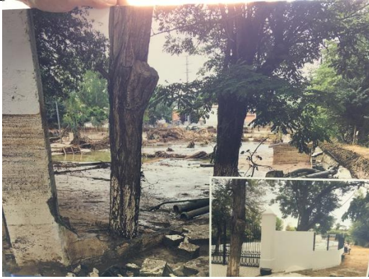
Foto 1. Inundación de 2018 en la instalación piscícola (fase B)
