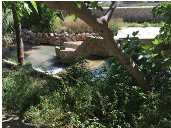
Foto 15. Obra de toma de la Fase C, aguas abajo del paso bajo la A-92, que incluye varios muretes y un azud
