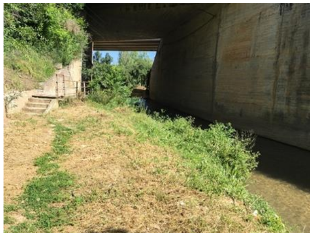
Foto 14. Paso bajo la autovía A-92, desde aguas arriba
