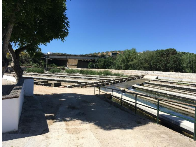
Foto 8. Fase C, desde la zona elevada que incluye las oficinas. Al fondo, muro de gavión construido tras la inundación de 2018
