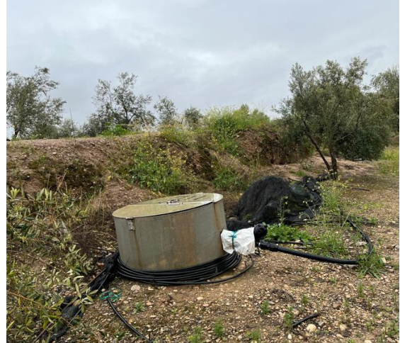
Foto 6. Arqueta de riego
