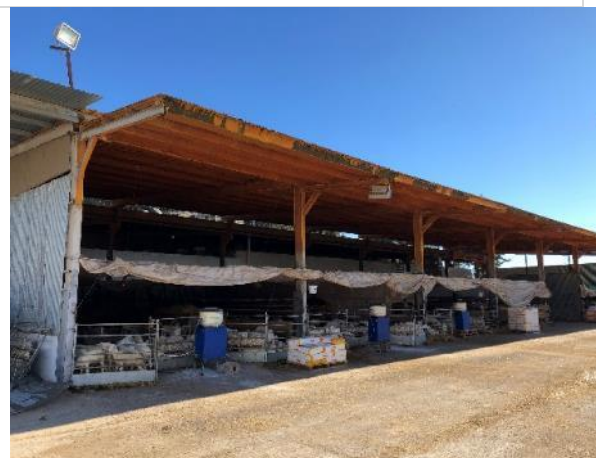
Foto 4. Nave de nodrizas. Pórtico de acceso
