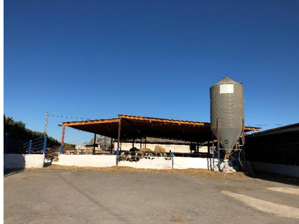
Foto 13. Silos tipo torre
