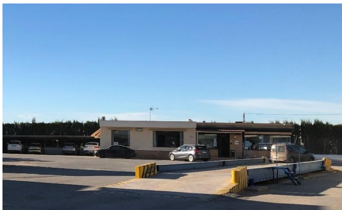
Foto 10. Oficinas situadas en la zona sur de la explotación, junto a la entrada
