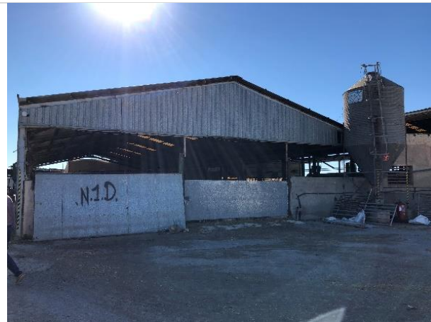
Foto 1. Naves de estabulación. Nave central
