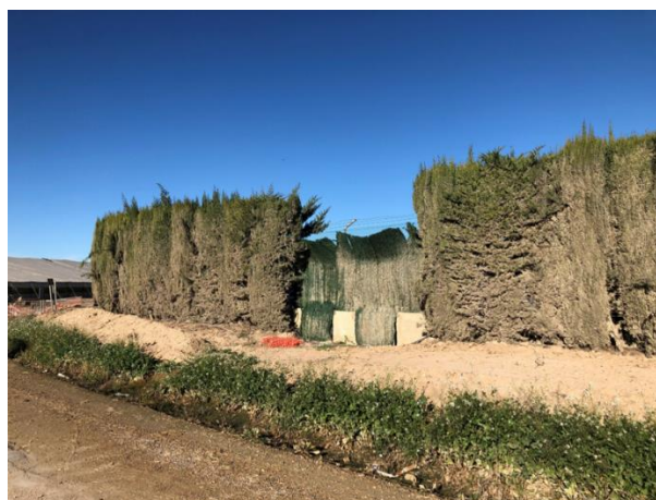
Foto 16. Cerramiento sur afectado por inundación remontante
