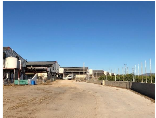
Foto 2. Naves de estabulación. Vista hacia el N
