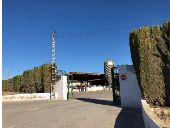
Foto 5. Nave de estabulación de terneros. Entrada exterior sur
