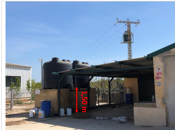
Foto 30. Depósitos de agua sobreelevados
