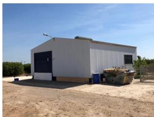
Foto 13. Desaladora. Acceso principal
