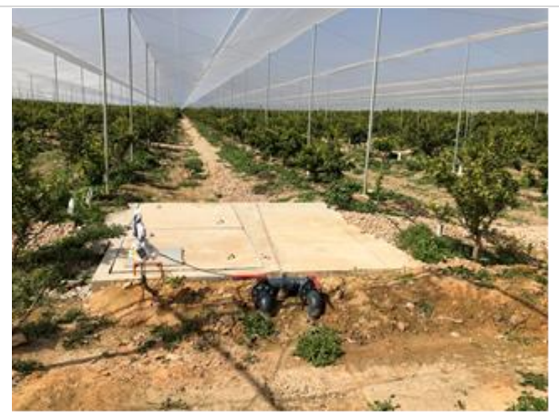
Foto 11. Arqueta de bombeo de los excedentes riego
