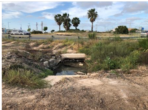
Foto 35. Marco que une el drenaje de la parcela y el Canal de drenaje D7. Vista hacia aguas abajo
