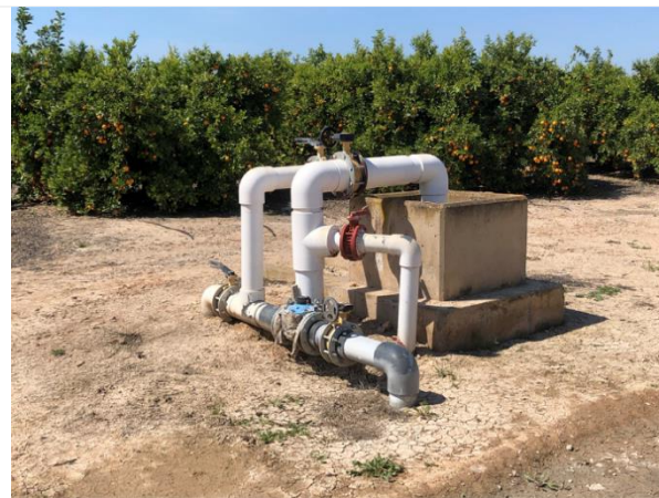
Foto 4. Bombeo desde el ATS
