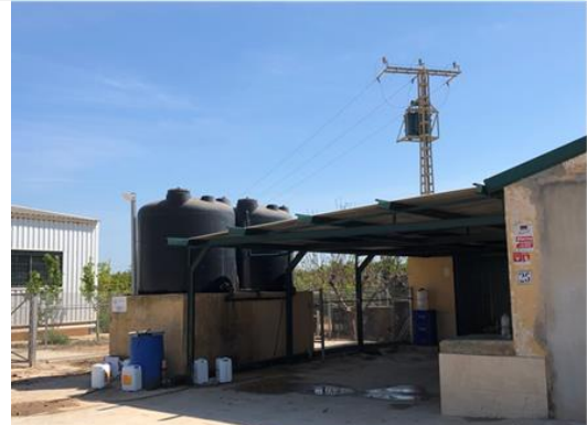
Foto 16. Área lateral este. Depósitos de agua
