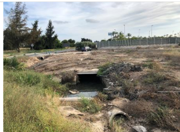
Foto 34. Marco que une el drenaje de la parcela y el Canal de drenaje D7. Vista hacia aguas arriba
