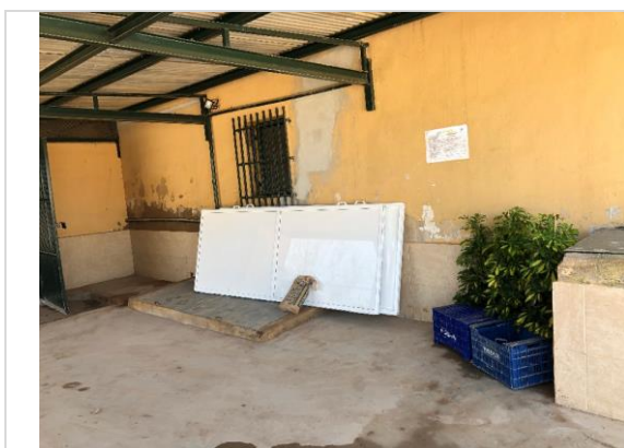
Foto 28. Compuertas de sellado anti-inundación para los portones de la nave de riego
