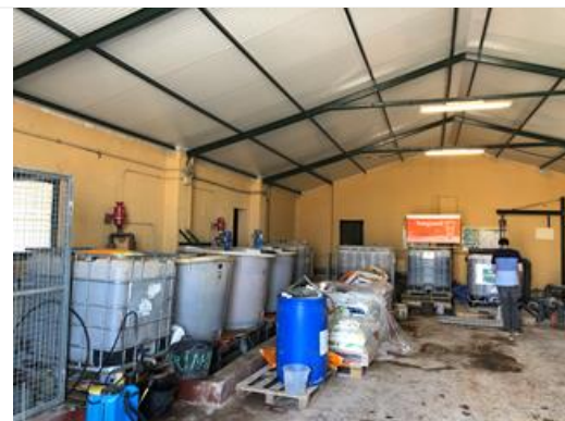
Foto 19. Nave de riego: área suroriental
