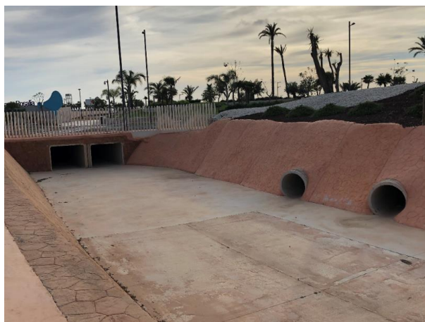
Foto 36. Canal de Drenaje D7. Vista hacia aguas arriba
