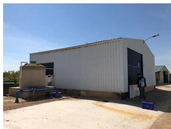
Foto 14. Desaladora. Fachada Este y pozo de bombeo
