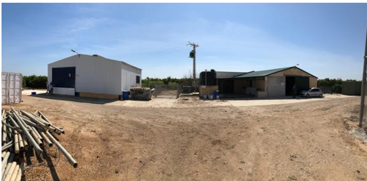
Foto 12. Panorámica de las instalaciones cubiertas: desaladora y nave de riego
