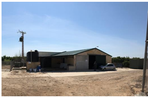
Foto 15. Nave de riego y transformador
