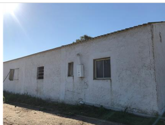
Foto 2. Ventanas en la fachada norte
