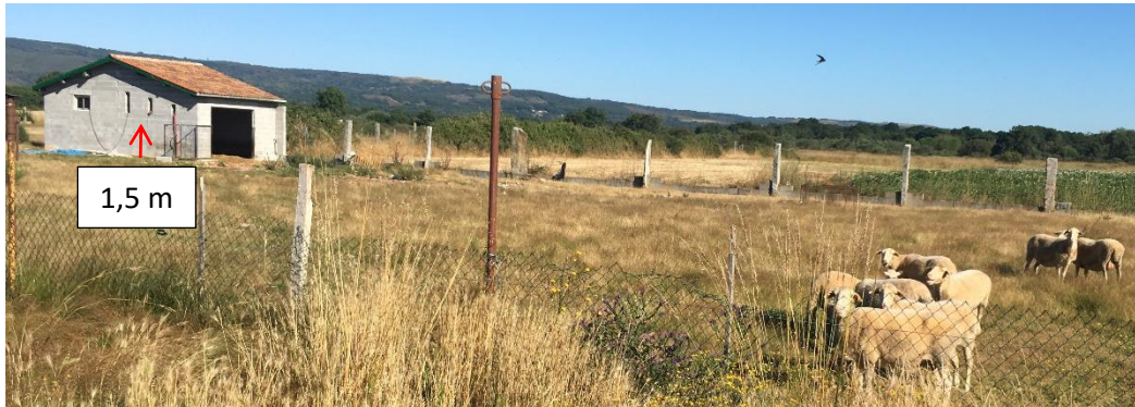
Foto 10. Caseta auxiliar a nivel del terreno natural y ubicación de rampa y superficie de protección a 1,5 metros.
