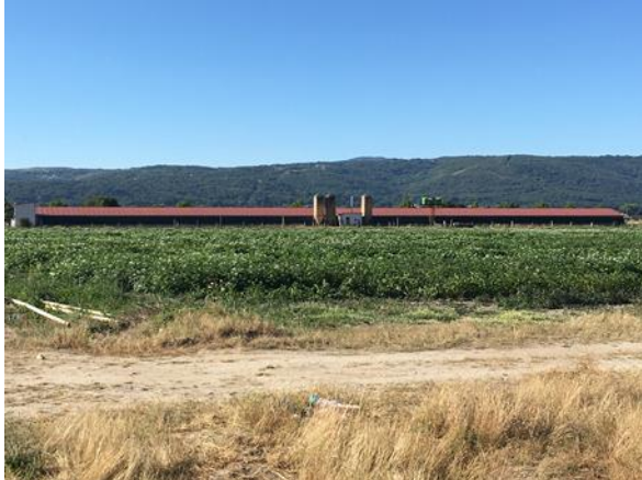
Foto 1. Nave. Vista lateral
