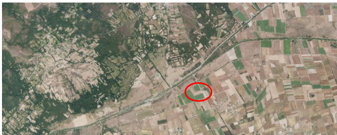
Figura 1. Canalización del río Limia aguas abajo de Xinzo de Limia. En el círculo rojo la explotación analizada.
