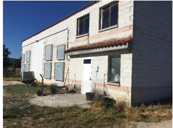
Foto 2. Nave. Puertas de acceso
