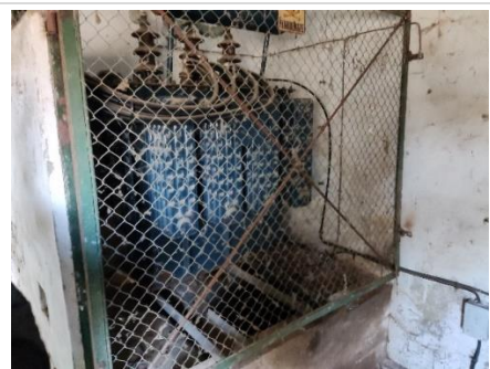
Foto 10. Transformador elevado
