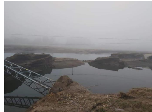
Foto 5. Cárcavas dentro de la explotación provocadas por las avenidas. Inundación de 2019
