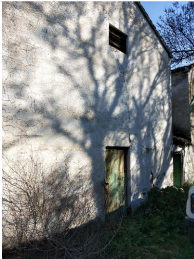
Foto 3. Edificación del transformador
