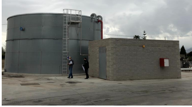
Foto 2. Caseta bombeo depuradora
