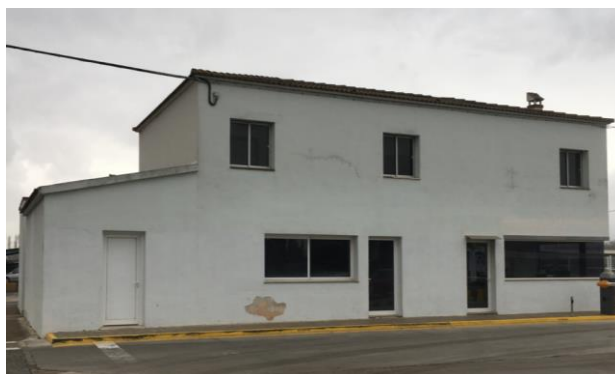
Foto 1. Caseta de recepción y control de acceso
