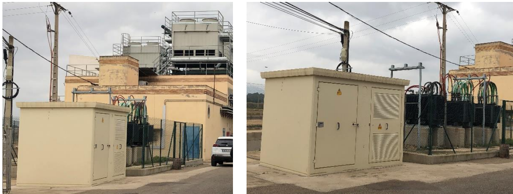
Foto 1. Zona de instalaciones eléctricas
