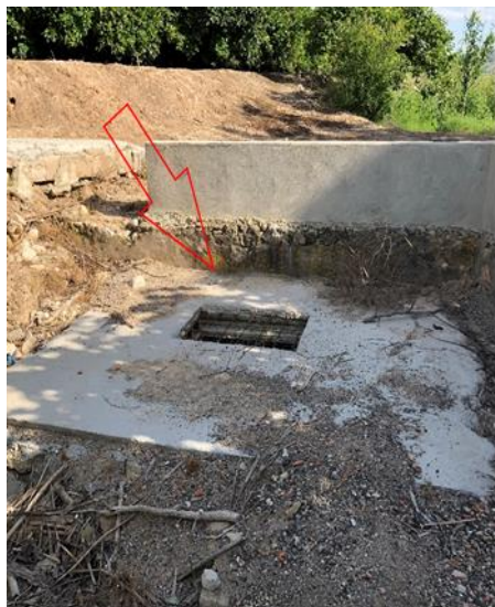
Foto 10. Punto de entrada al tramo subterráneo de la RAC a través de respiraderos
