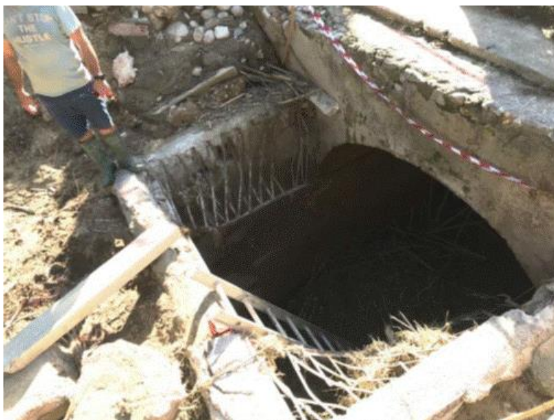
Foto 14. Entrada al tramo subterráneo
