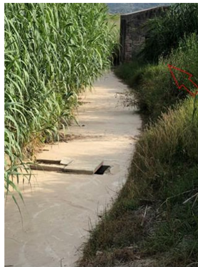
Foto 11. Punto de entrada al tramo subterráneo de la RAC a través de aliviaderos
