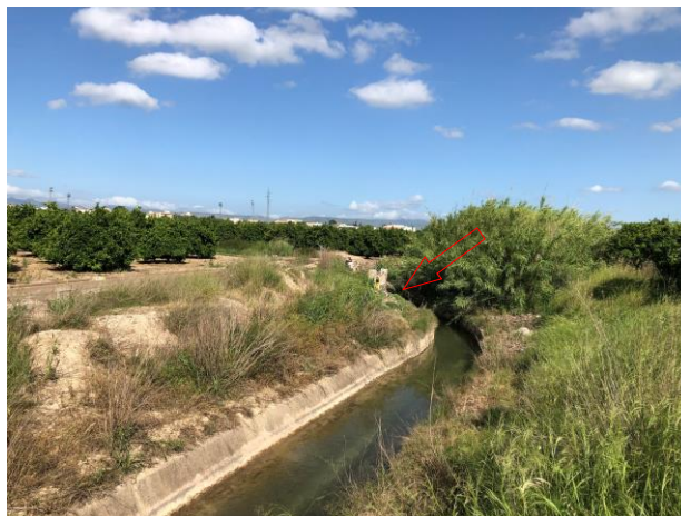
Foto 9. Punto de entrada del agua en el inicio del tramo subterráneo
