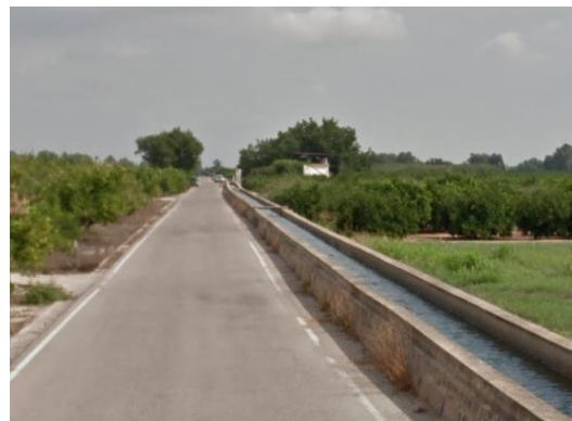
Foto 4. Acequia con cotas superior al terreno
