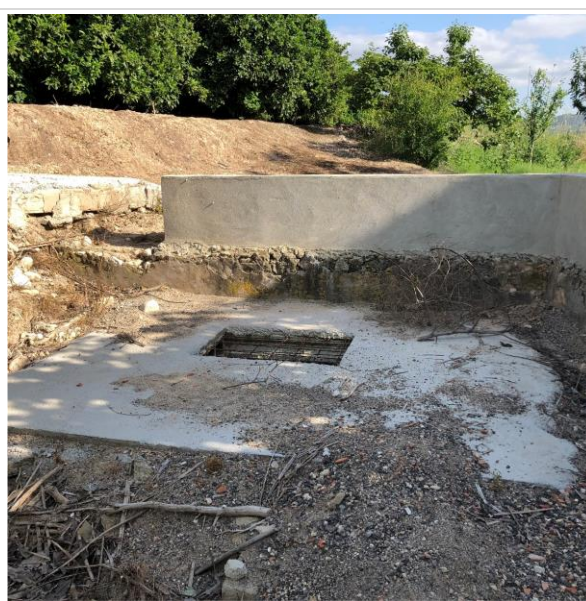
Foto 13. Muro de hormigón para protección de respiraderos
