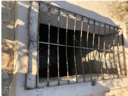
Foto 2. Respiradero tipo y reja protectora
