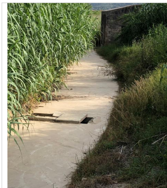
Foto 12. Respiradero sellado con una tapa de hormigón
