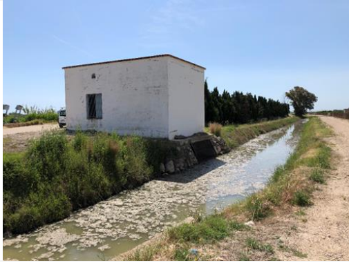
Foto 11. Caseta de bombeo nº 5
