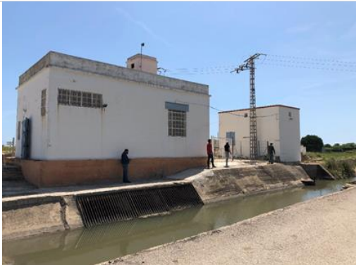
Foto 15. Caseta de bombeo nº 6
