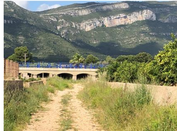
Foto 24. Entrada del barranco a la comunidad a través de puente de 9 ojos sobre la N-332
