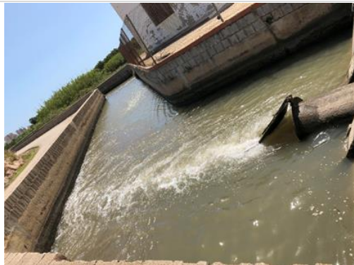
Foto 16. Bombeo nº 6 en funcionamiento
