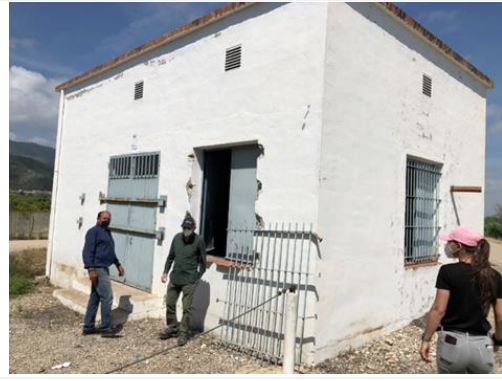
Foto 12. Caseta de bombeo nº 4
