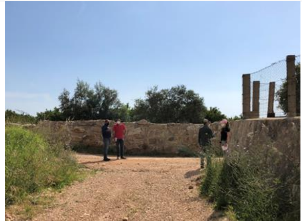
Foto 25. Muro a la entrada del barranco a la comunidad. Altura de unos 1,8 m
