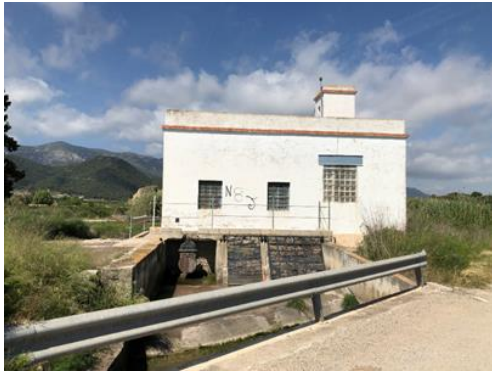
Foto 13. Caseta de bombeo nº 3
