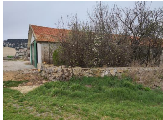
Foto 4. Muro perimetral de protección
