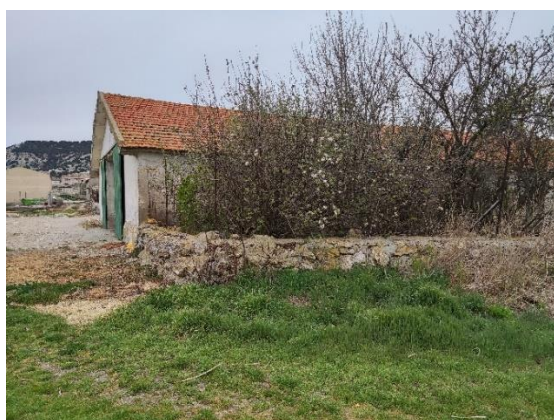
Foto 9. Murete de protección
