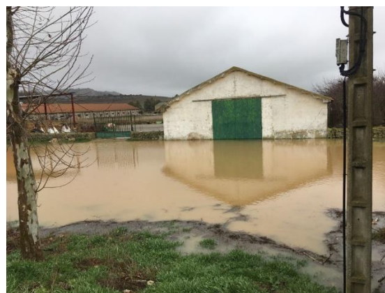
Foto 10. Nave inundada, puerta sin protección
