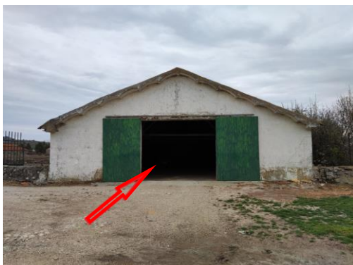
Foto 5. Entrada a nave almacén (1)
