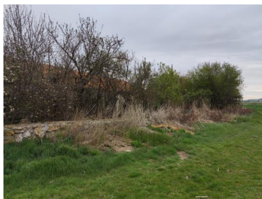
Foto 8. Muro de mampostería permeable
