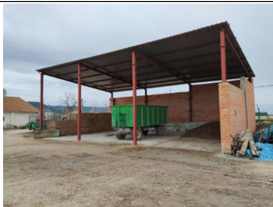
Foto 6. Porche completamente abierto (2)
