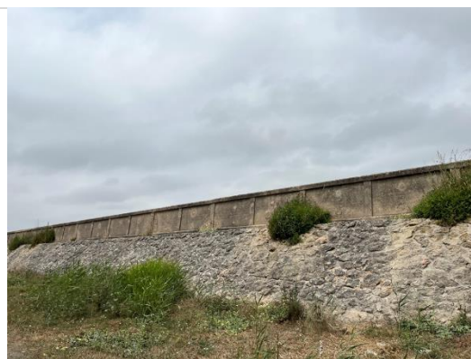
Foto 4. Canal de transporte sobreelevado
