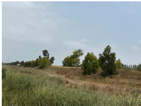
Foto 6. Dique, lado sur
