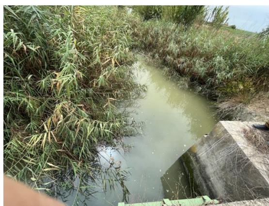
Foto 15. Arroyo Carrillo. Salida al Guadalete
