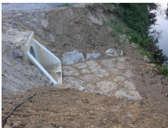
Foto 15. Ejemplo de embocadura de hormigón prefabricado con enchachado
