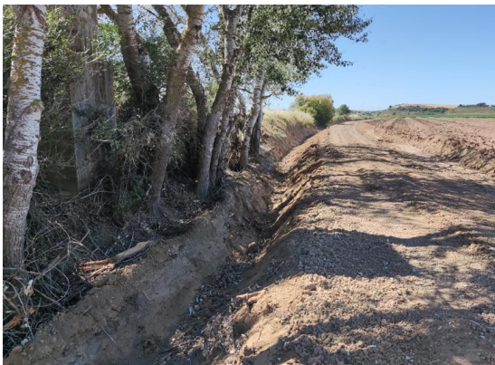
Foto 13. Construcción de nuevo drenaje
