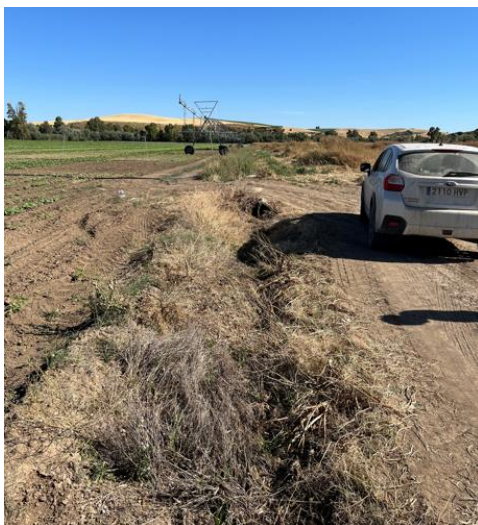
Foto 3. Acequia de drenaje
