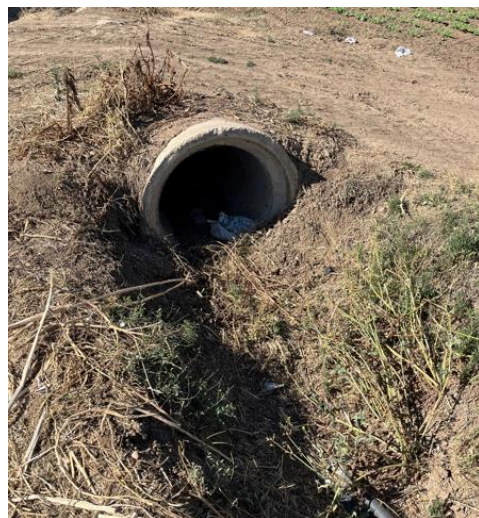
Foto 4. Paso inferior de agua
