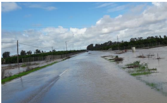
Foto 10. Efecto dique de la carretera
