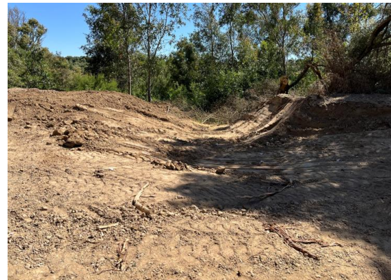
Foto 14. Movimiento de tierras y salida de agua al río
