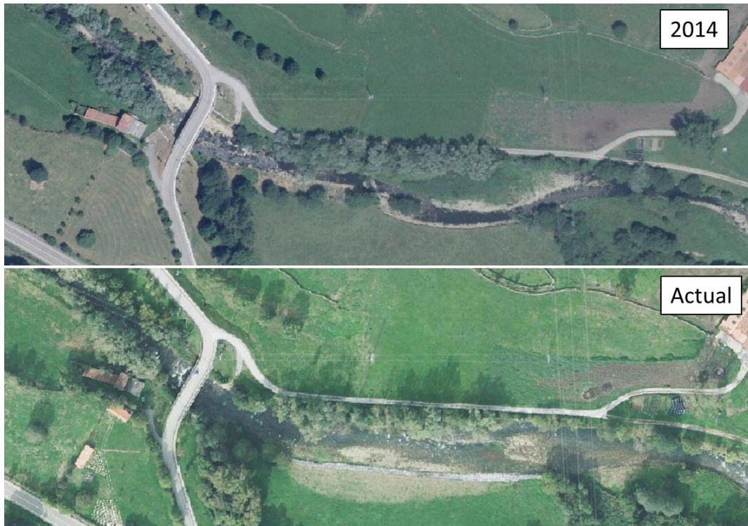
Figura 8. Ortofotos del tramo de cauce justo aguas arriba del puente que da acceso a Bárcena de Carriedo. En la foto actual se aprecia el muro de escollera construido en 2020 para proteger la erosión de la margen izquierda.
