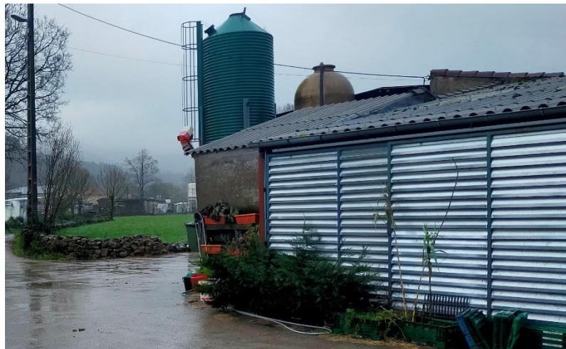
Figura 12. Elementos de ventilación situados en la pared de la sala de ordeño.
