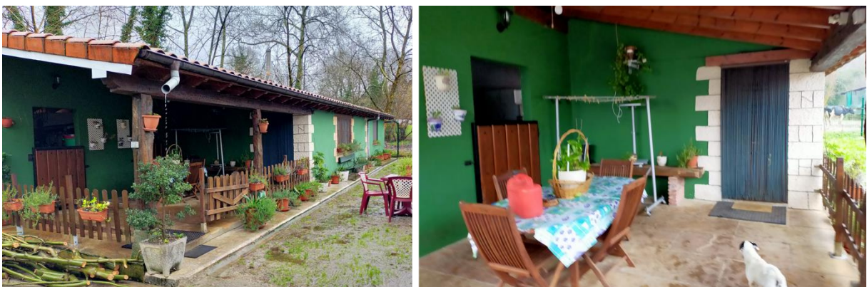
Figura 2. Edificio principal en el que se ubica una oficina y un almacén de herramientas.
