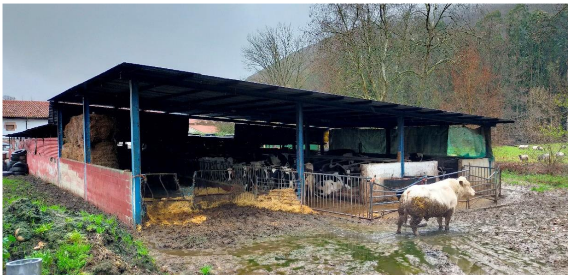
Figura 13. Muro lateral (sur) y frente abierto (este) de la nave establo.
