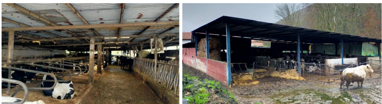
Figura 4. Nave establo tomadas desde el flanco oeste (izquierda) y este (derecha).
