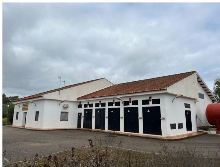
Foto 7. Edificios del centro control y transformador. EB del Mohino
