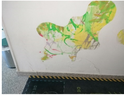
Pasillo contiguo al acceso calle Bézquiz.
