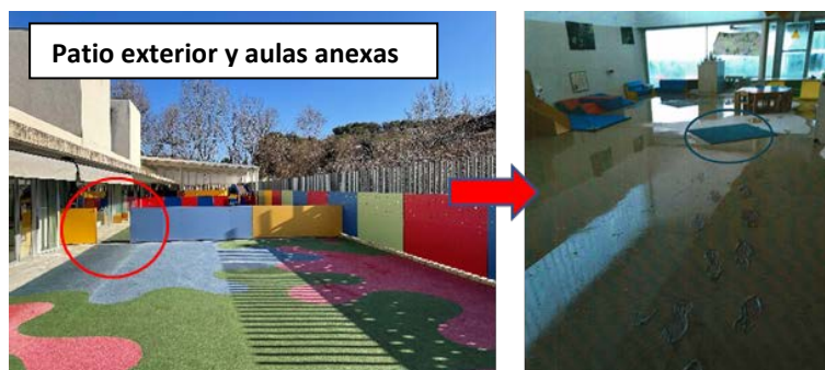
Figura 29. Patio exterior y aula anexa anegada durante las inundaciones de julio de 2019
