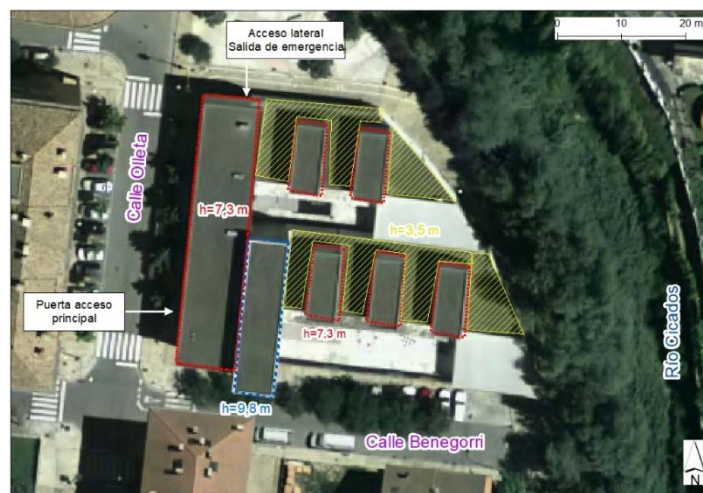
Figura 17. Detalle de las diferentes alturas de los bloques del edificio
