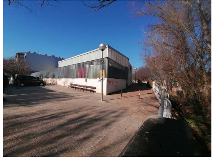
Esquina fachada sur con este, con el río Cicados a la derecha
