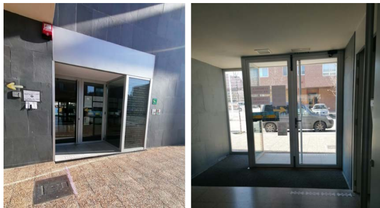
Figura 19. Entrada principal vista desde fuera y desde dentro, desde la calle Olleta
