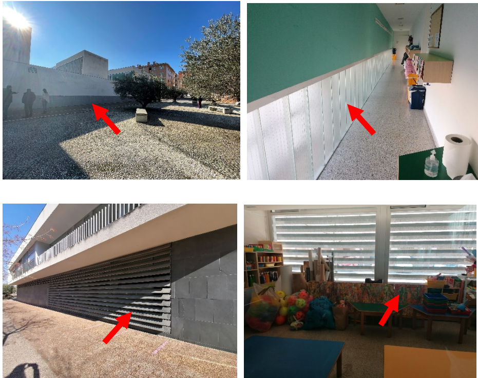
Figura 46. Instalación de cristales resistentes a la inundación
