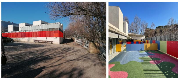
Figura 42. Muro existente a recrecer en patio exterior, delimitante con la calle Benegorri
