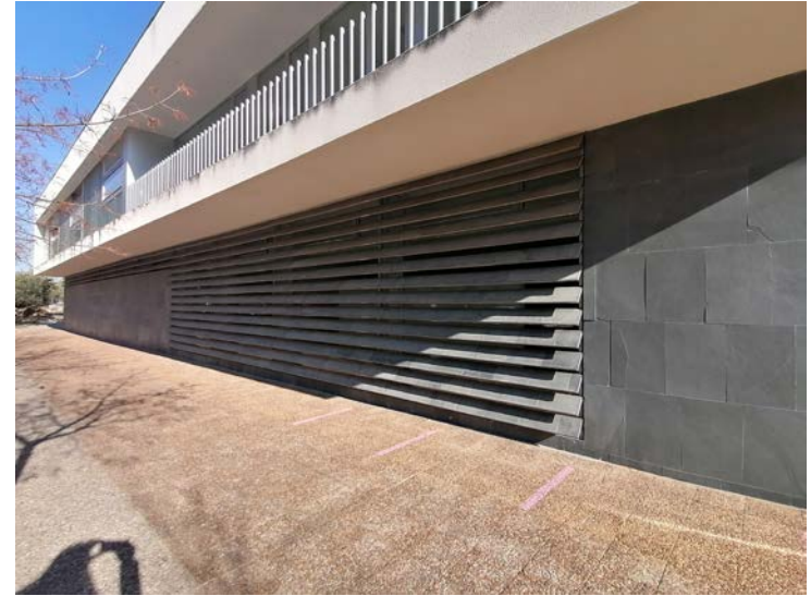
Estructura metálica para dar luz al interior del aula de la planta baja
