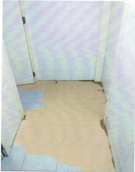
Acceso vestuarios y cocina
