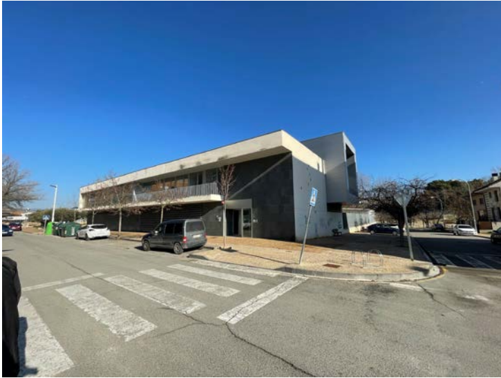
Fachada oeste, puerta de entra principal, calle Olleta
