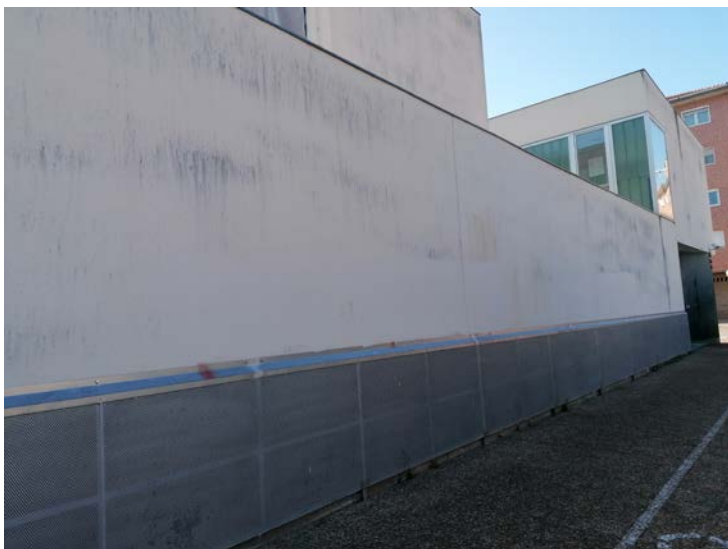
Detalle de rejilla sobre ventanales para dar luminosidad en la fachada Norte
