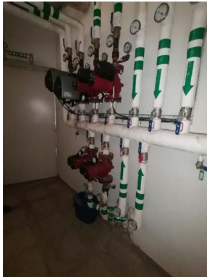
Tuberías de la calefacción y termo de agua caliente
