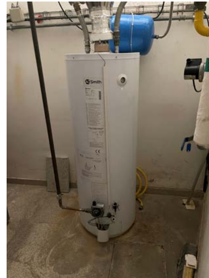
Tuberías de la calefacción y termo de agua caliente
