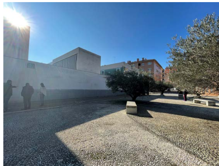
Vista del edificio al sur de la zona asfaltada
