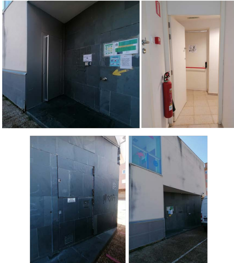
Figura 20. Entrada lateral, salida de emergencia, acceso al cuadro eléctrico en el lado norte del edificio
