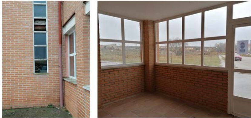
Figura 18. Detalle de los ventanales ubicados en la zona de acceso oeste
