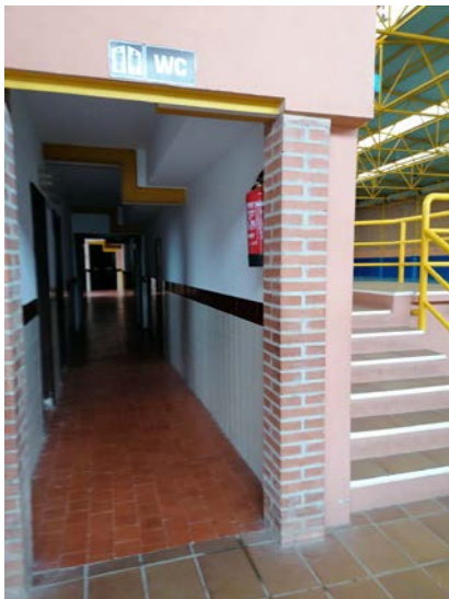
Pasillo bajo las gradas acceso a baños y vestuarios
