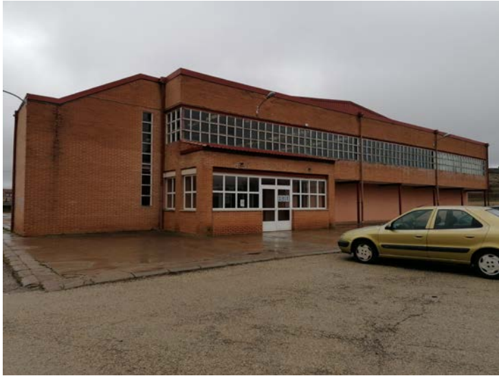
Fachada NO del pabellón y puerta de acceso principal
