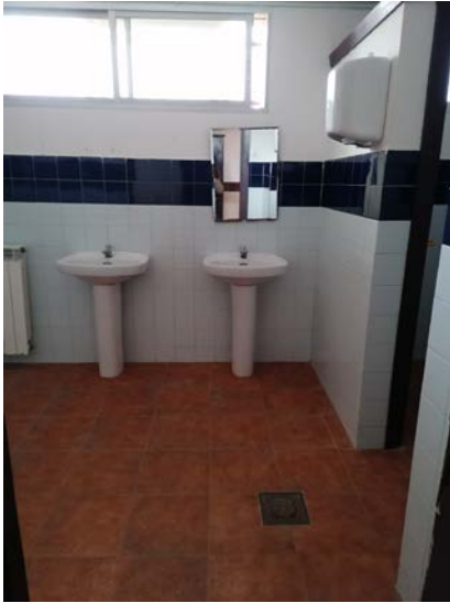
Baños y rejilla de desagüe
