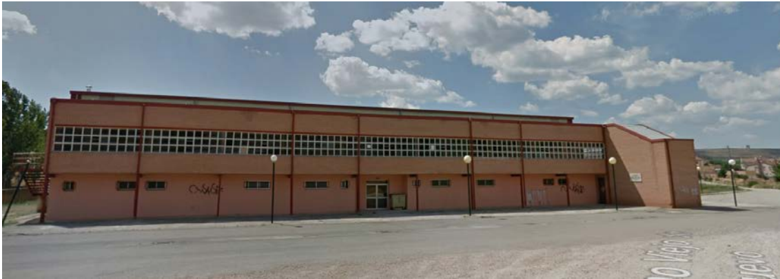
Figura 12. Fachada norte del polideportivo
