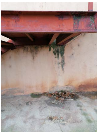
Detalle de las grietas y humedades observadas durante la visita en la fachada del pabellón deportivo
