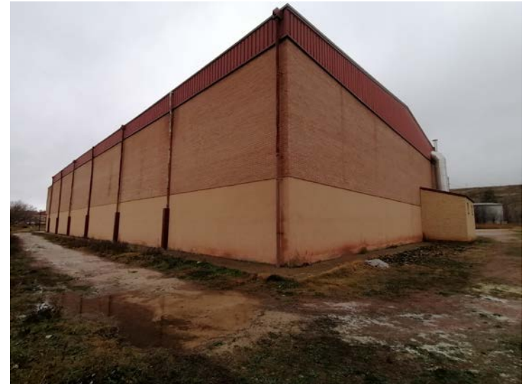
Vista de la esquina fachadas SE-SO
