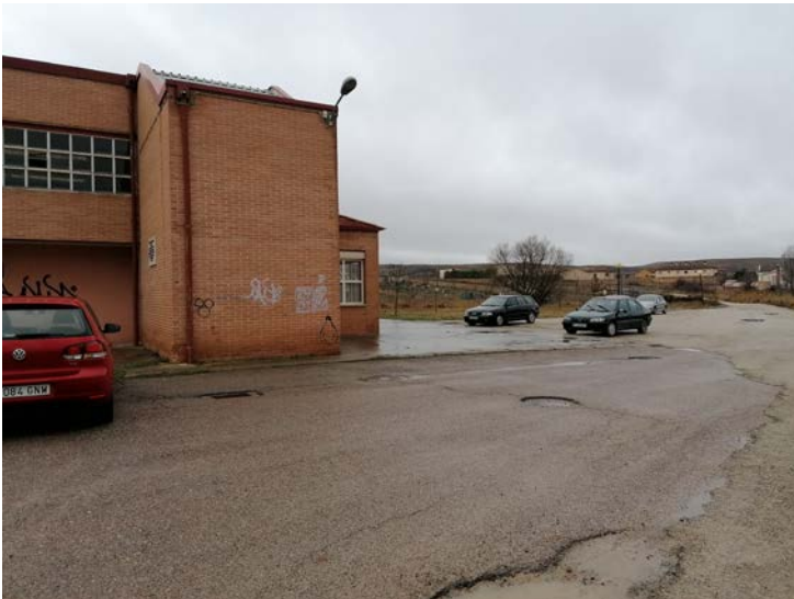
Vista del pavimento en la cara NE del pabellón y aparcamiento
