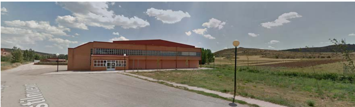
Figura 13. Fachada oeste del polideportivo
