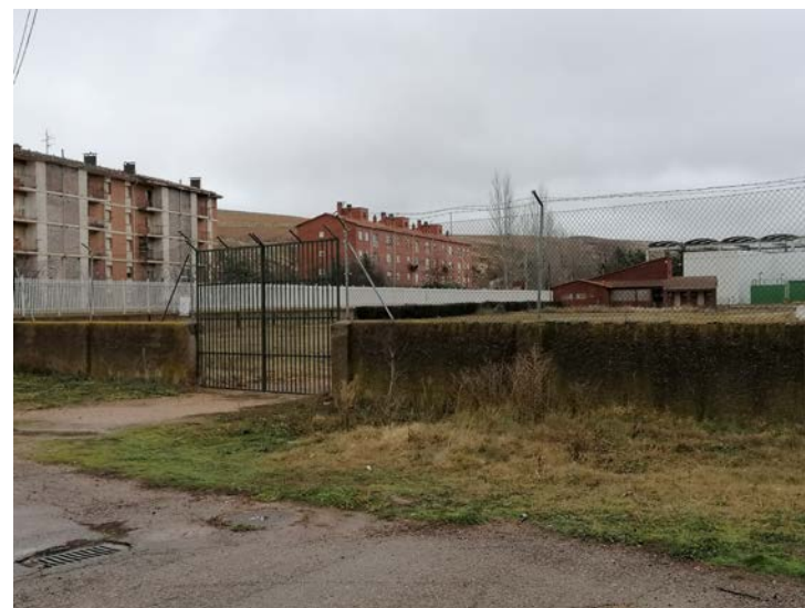
Rejilla y alcantarilla al SE lindando con el muro de la parcela adyacente
