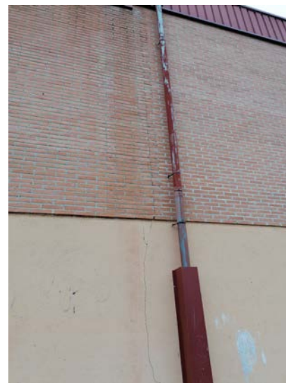
Detalle de las grietas y humedades observadas durante la visita en la fachada del pabellón deportivo
