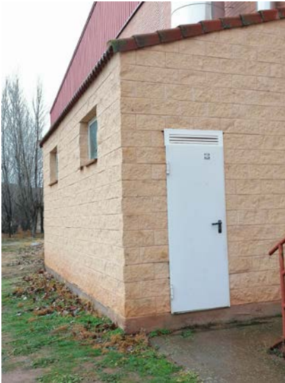
Puerta de acceso al cuarto de la caldera, 20 cm elevada sobre cota terreno
