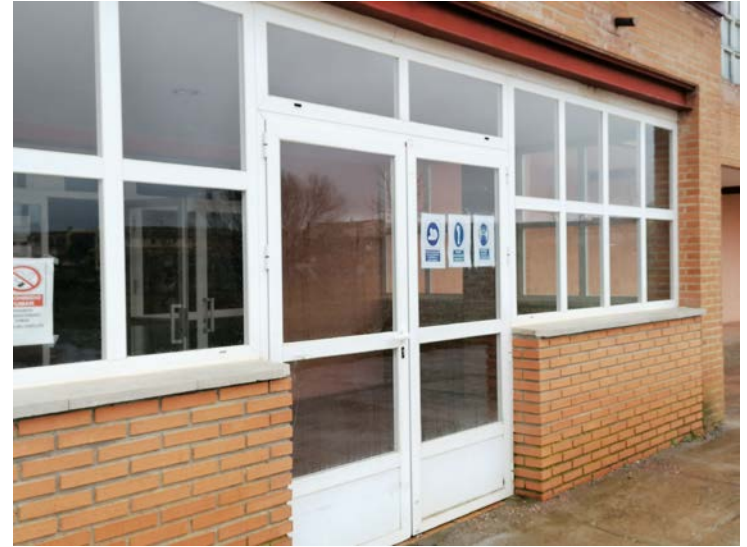
Detalle de la puerta de acceso principal
