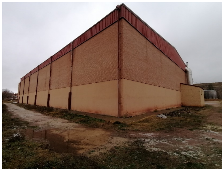
Figura 21. Detalle del cuarto de calderas y canalones del pabellón
