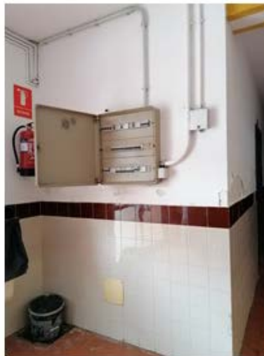
Figura 22. Equipamiento del pabellón
