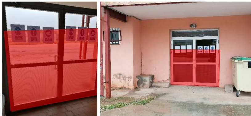
Figura 30. Puerta a proteger, con una barrera temporal apilable. Puerta Fachada Norte.
