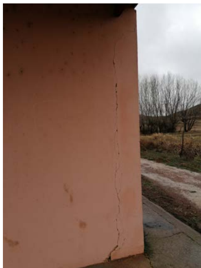
Detalle de las grietas y humedades observadas durante la visita en la fachada del pabellón deportivo
