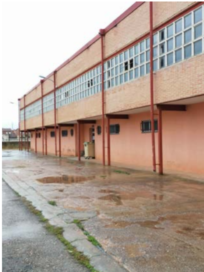
Fachada NE del pabellón
