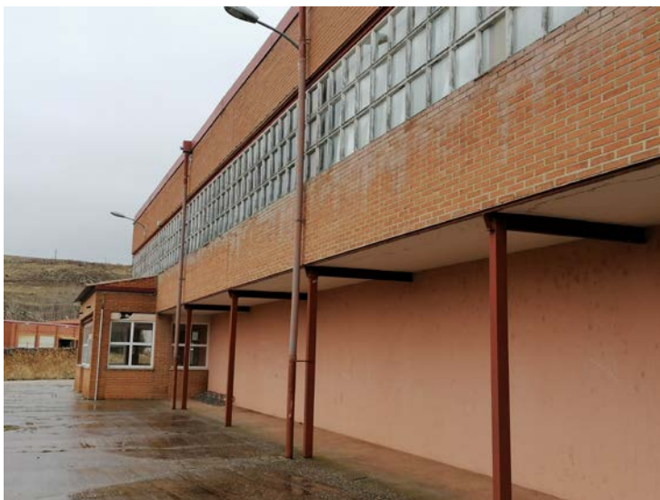
Vista lateral de la entrada principal
