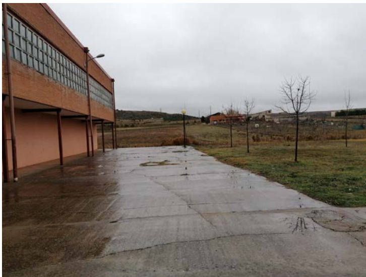
Vista del pavimento delante de la fachada NO y zona ajardinada
