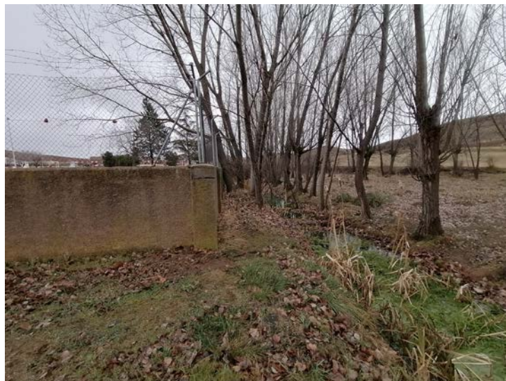
Muro delimitador parcela al SE y reguero a la derecha
