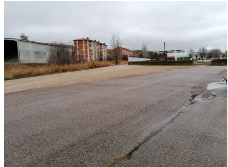
Pavimento en el acceso NE a la parcela
