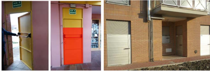
Figura 32. Puerta a proteger, con un panel de aluminio. Puerta Salida Emergencia. (Fuente: Aquastop)
