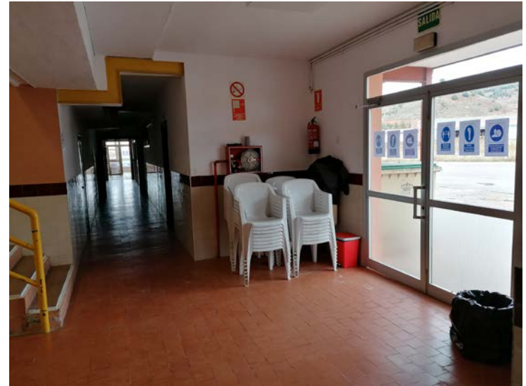
Vista de la entrada desde la fachada NE
