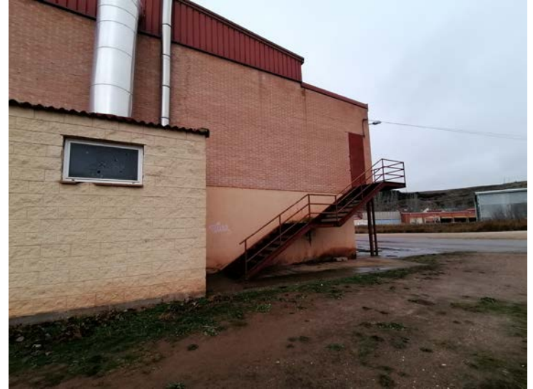
Fachada SE, cuarto de calderas a la izquierda y escalera exterior de acceso a las gradas
