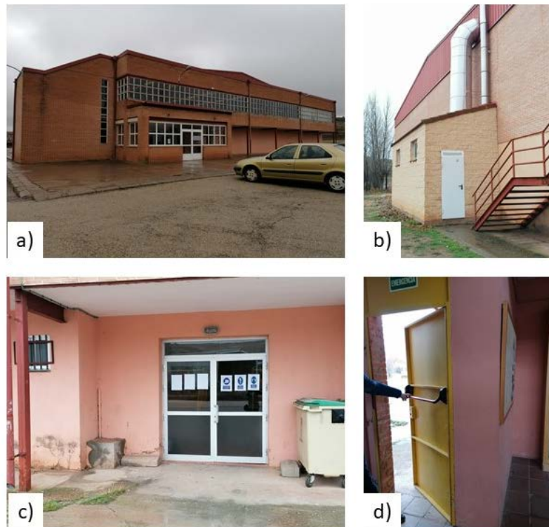
Figura 17. Accesos al pabellón: a) puerta oeste; b) acceso este a cuarto de calderas; c) puerta acceso norte y d) salida de emergencia al norte
