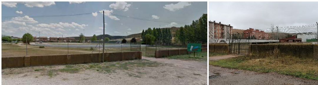
Figura 28. Murete perimetral existente a recrecer en pista deportiva anexa
