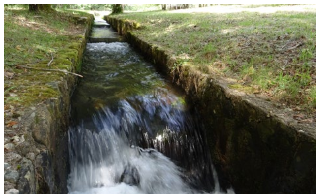
Encauzamiento en la reserva natural fluvial de la Ribeira Grande
