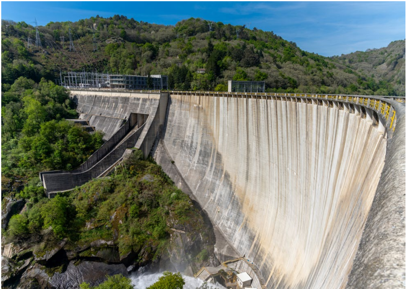
Central hidroeléctrica de Belesar
