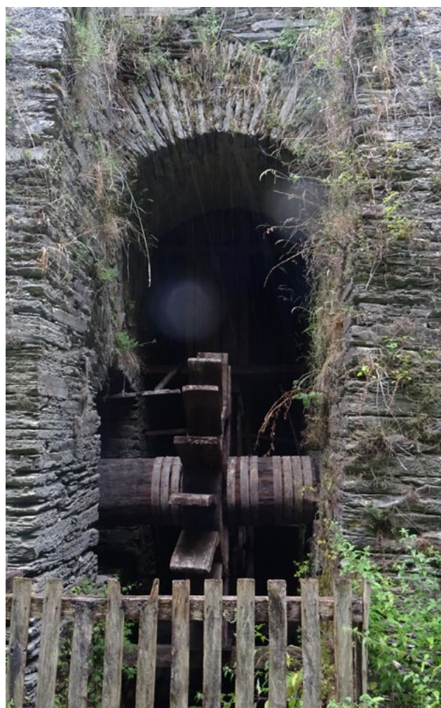
Estructura tradicional en la demarcación del Miño-Sil
