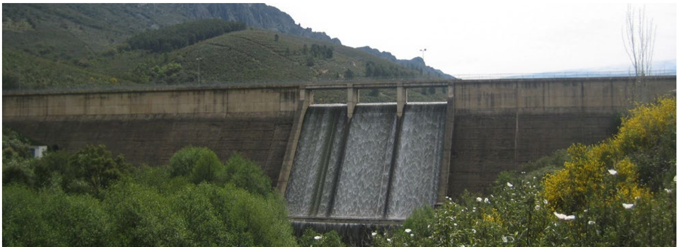
Presa de Trujillo-Santa Lucía
