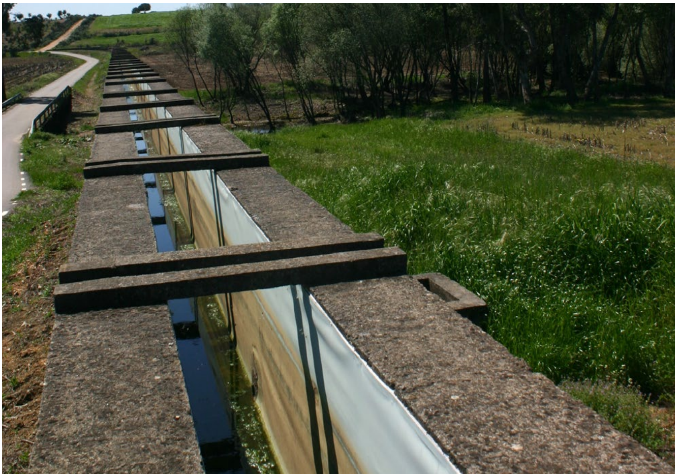
Acequia en el municipio de Cilleros (Cáceres)
