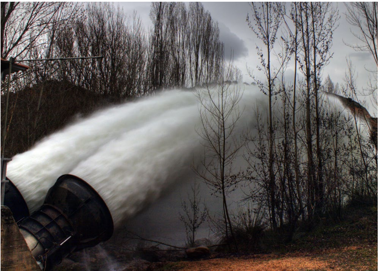
Presa de Beleña
