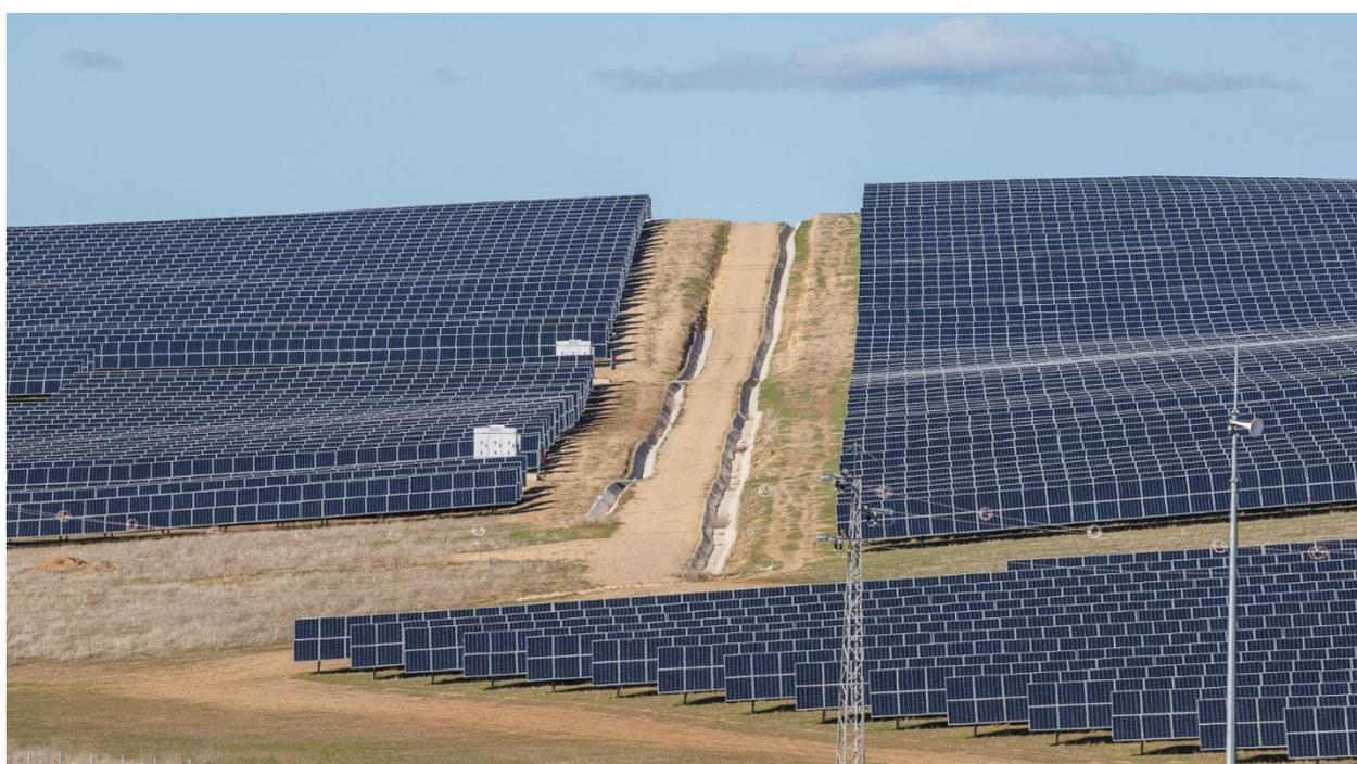
*Foto 3-15. Las cunetas y drenajes han de ser correctamente diseñados para evitar impactos de atrapamiento en fauna terrestre de movimientos limitados, como determinados anfibios y reptiles. Foto: Daniel Burón.*
