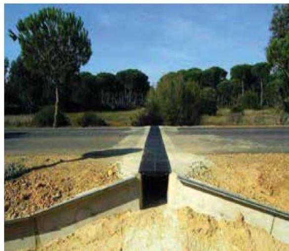
Paso para anfibios bajo carretera con estructura de guía que conduce a los microvertebrados hacia el conducto. De (Ministerio de Agricultura, Alimentación y Medio Ambiente, 2015).
