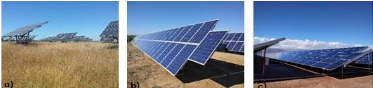
Figura 4-16 . Tipos de estructura fotovoltaica. (a) Seguidor a dos ejes. (b) Seguidor a un eje (horizontal). (c) Fija.
