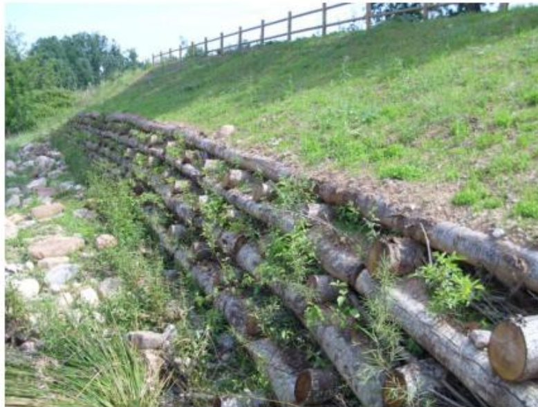
Imagen 2: Resultado de un talud tras la revegetación producida por las especies vegetales introducidas en el entramado vivo.
