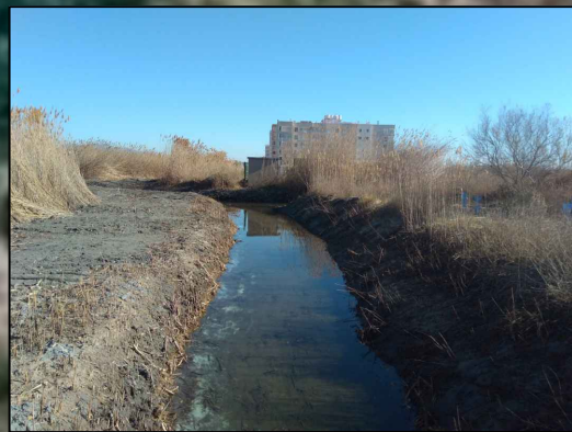
VISTA ACEQUIA DE LES PITERES (EXISTENTE)
