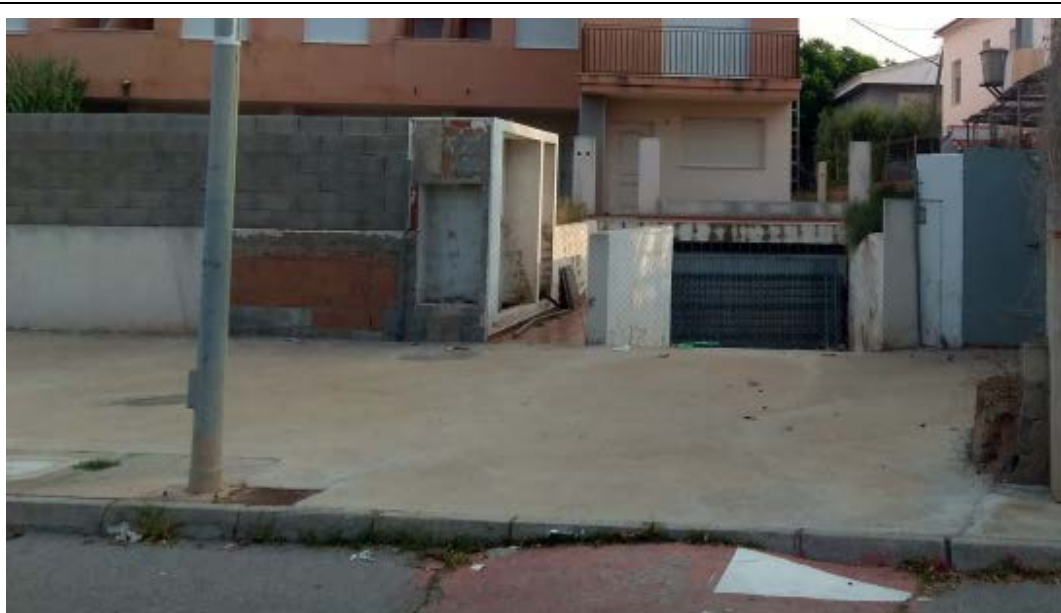
Imagen 15: Vista del hueco para el CGP en Passeig de Vora Riu.
