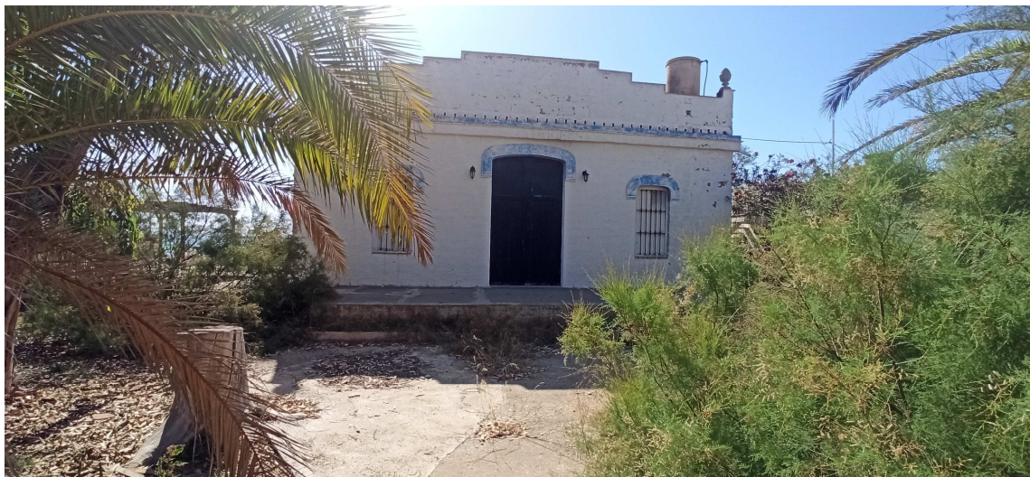
Fachada Oeste de la edificación principal
