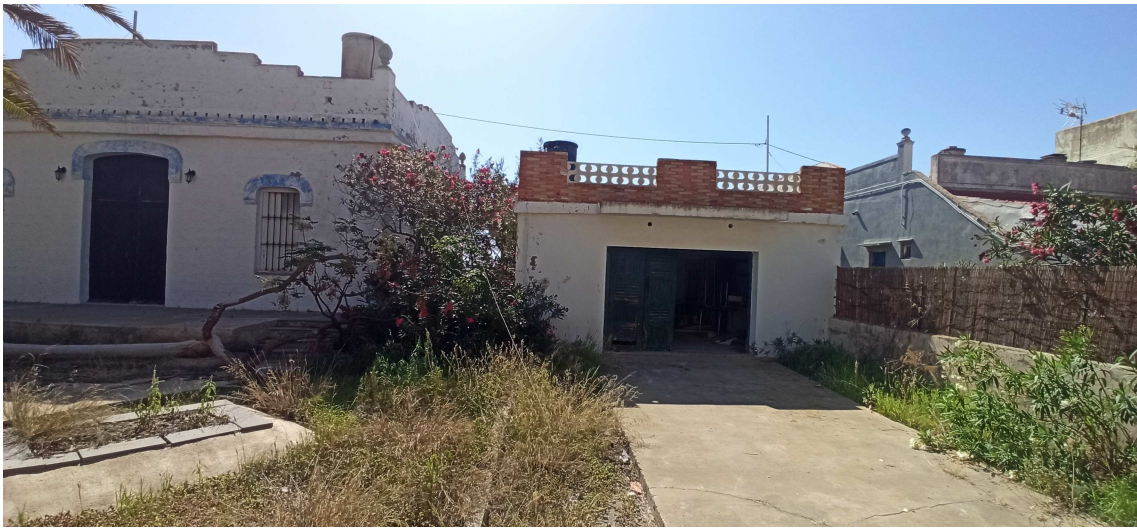
Fachada Oeste del conjunto, (a la derecha el garaje / almacén)
