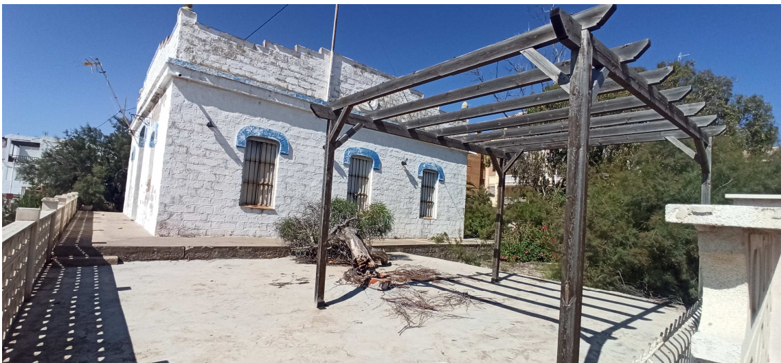
Fachada Norte de la edificación principal
