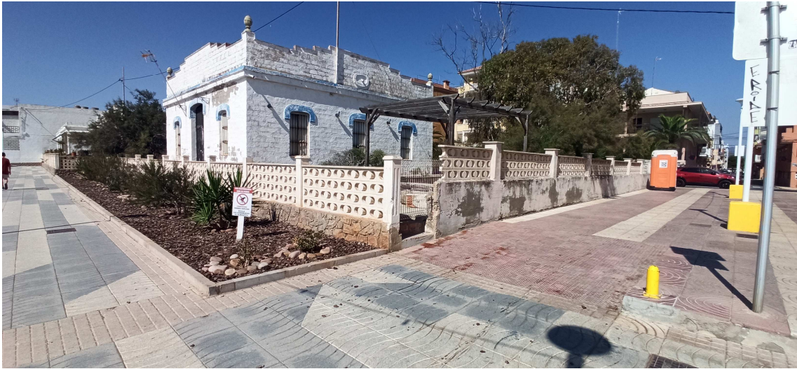
Vista de la parcela y edificación principal desde el paseo marítimo
