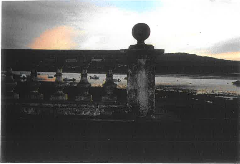
16.- Detalle balastrada del puerto.
