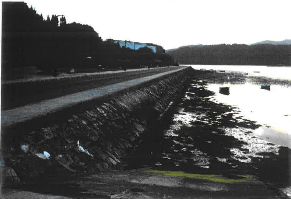
17.- Escollera del puerto. Punto de instalación de pasarelas de madera para amarre de pequeñas embarcaciones a las que se accede por escaleras de madera fijadas al talud.
