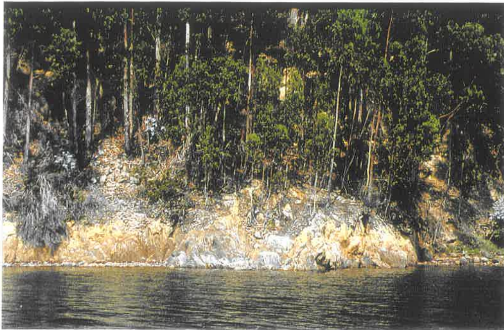
9.- Vista de la costa donde se observa la ausencia total de vegetación autóctona y la inestabilidad de los taludes.
