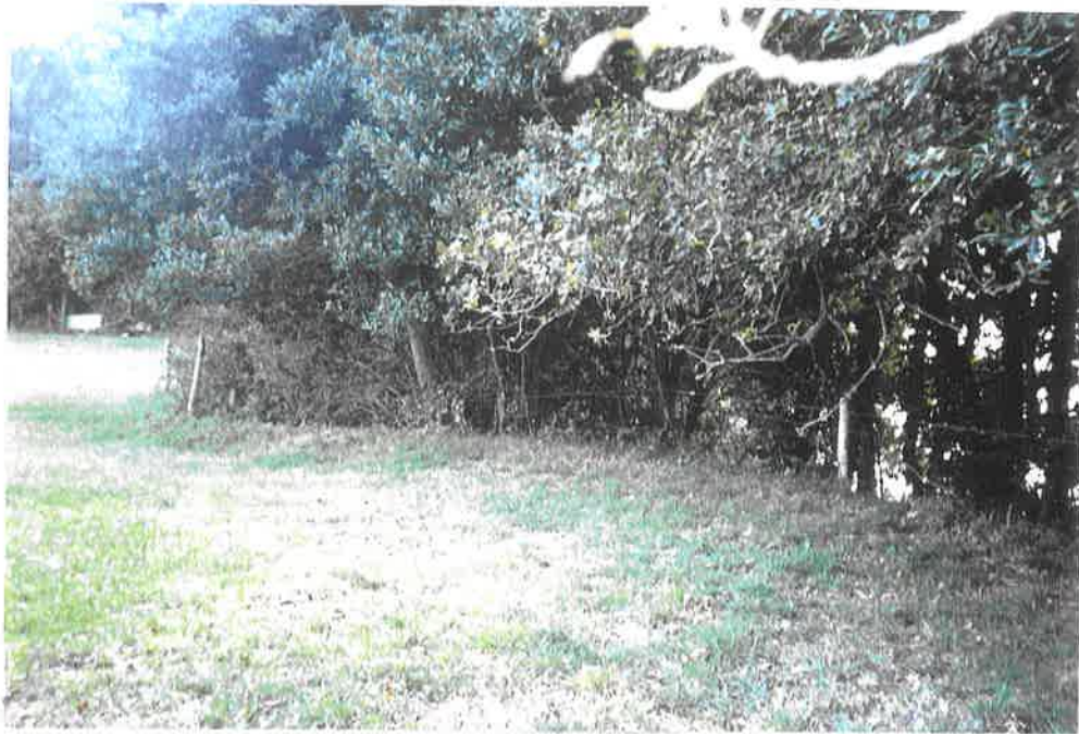
14.- Tramo del sendero que discurre por prado con cierre de alambrada metálica y postes de madera invadiendo el dominio público marítimo-terrestre. Conserva ejemplares de arbolado autóctono al borde del talud.
