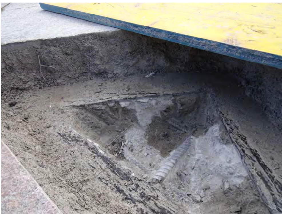
Figura 4: Cata realizada en la cara superior del forjado que forma el Mirador
