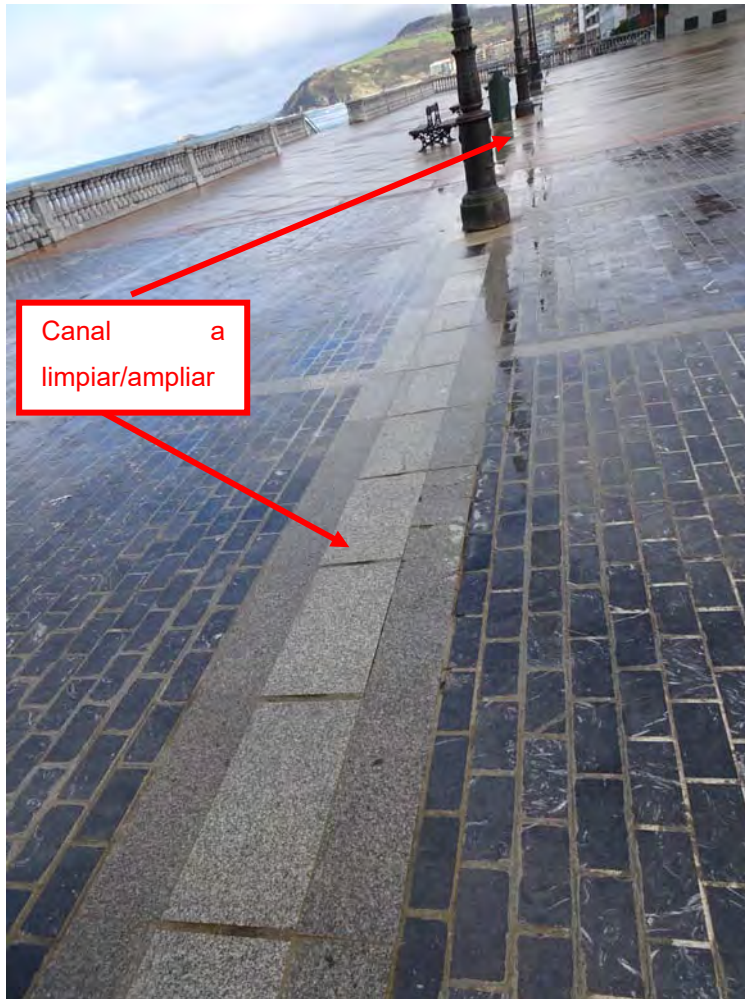
Figura 8: Canal a limpiar/ampliar en la plaza sobre el Mirador
