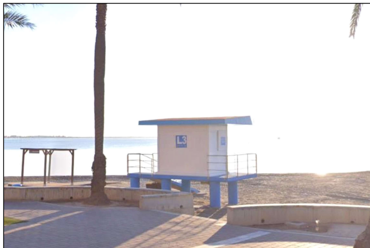
Foto 2. Caseta de vigilancia de playas LIMA 3 sobre la que se propone instalar la cámara en la Playa de Colón. Fuente: Google Maps (sept.-2022).
