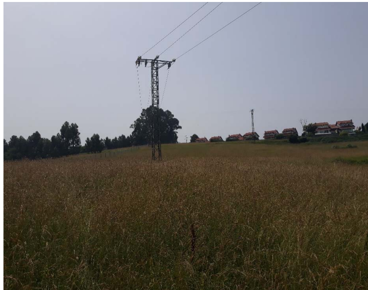
Líneas aéreas desmontar
