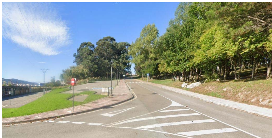
Líneas aéreas desmontar y zonas a ejecutar canalización
