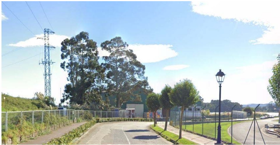
Líneas aéreas desmontar y zonas a ejecutar canalización
