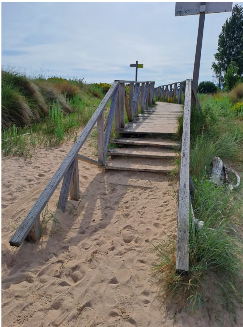
Fotografía 4. Inicio de la pasarela en la zona de playa
